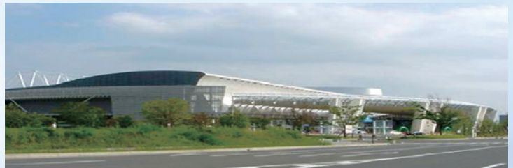
▲管端つば出し加工(フレア加工)が使用された大型施設
