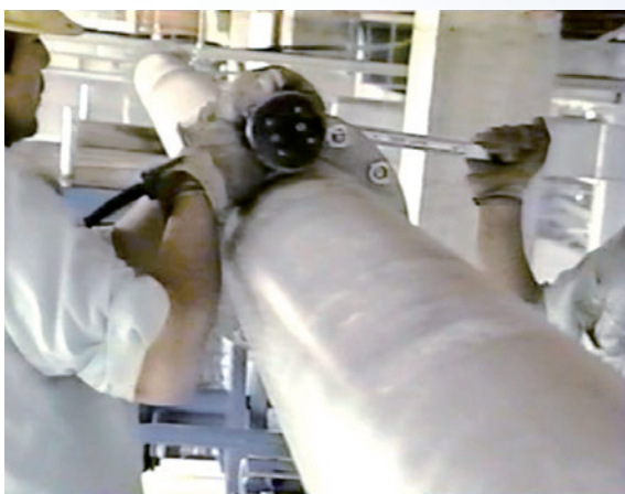
▲管端つば出し加工(フレア加工) 配管施工事例
