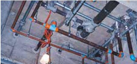
給水、中水、排水に使用されたライニング鋼管 (VA、PA、D-VA)
