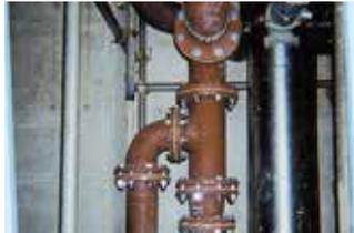
給水設備配管に使用されたフランジ付塩ビライニング鋼管 (FVA)
