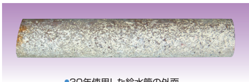
●30年使用した給水管の外観
