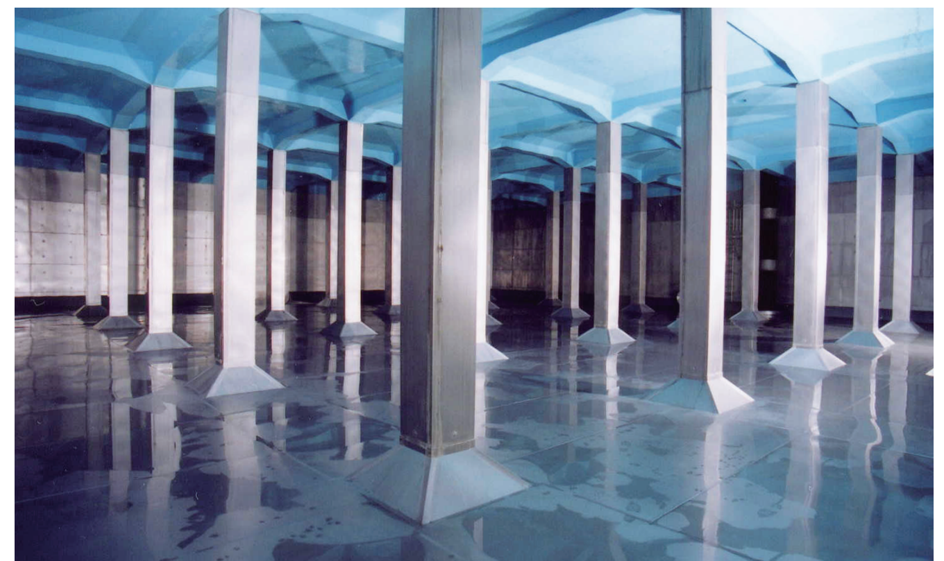
上越市ガス水道局 殿 容量：3,500m 3 ×2 寸法：25.8m×27.0m 高さ：5.2m(SUS) 老朽RC配水池のステンレス鋼板内張りによる改築
