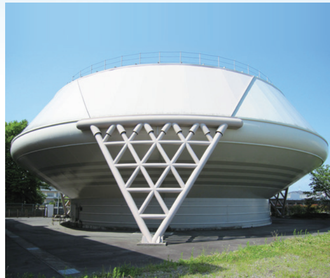
静岡市上下水道局 殿 容量：5,000m 3 直径：30.8m 高さ：14.5m
