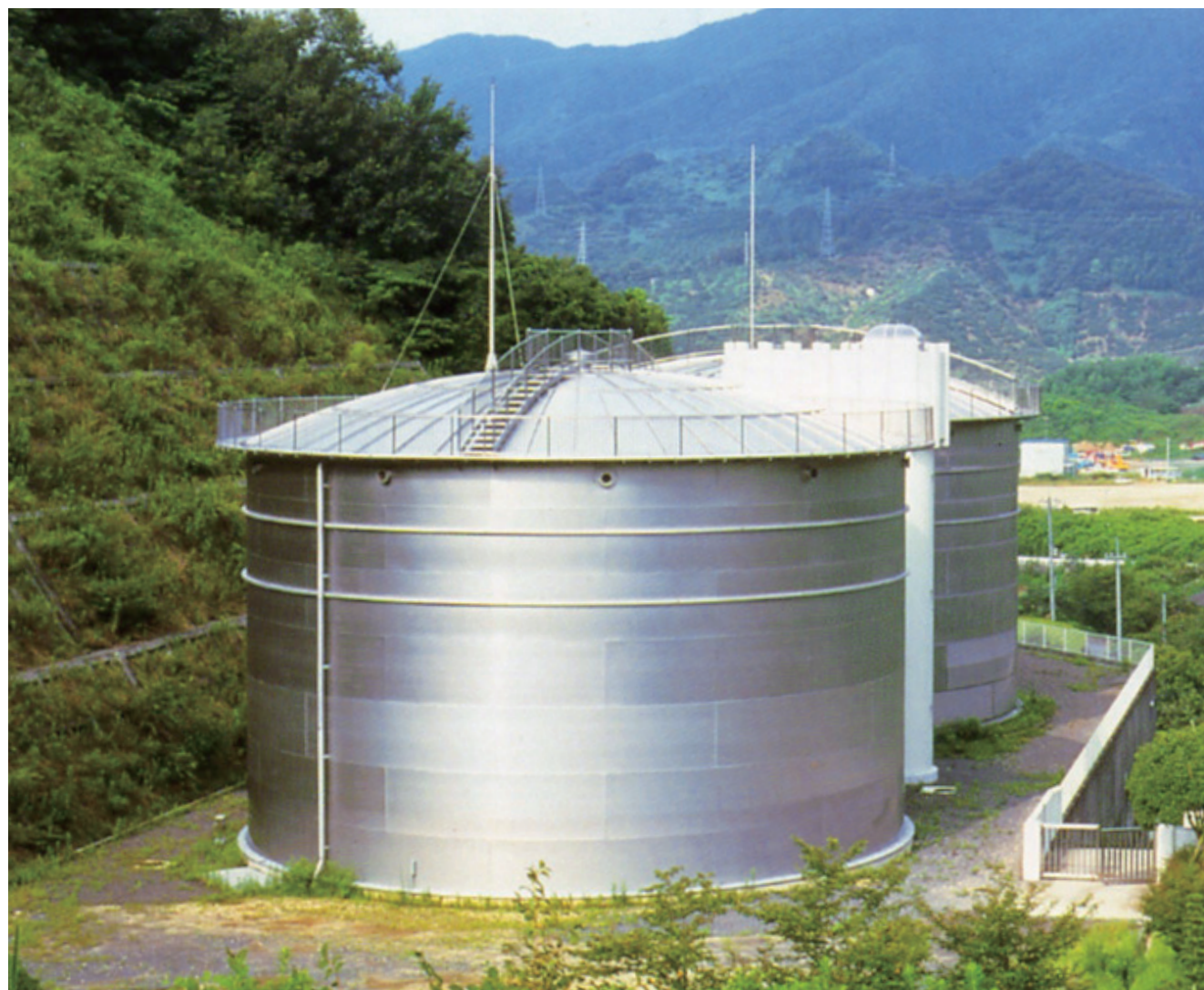
松山市公営企業局 殿 容量：4,600m 3 ×2 直径：26.3m 高さ：14.2m(SUS)
