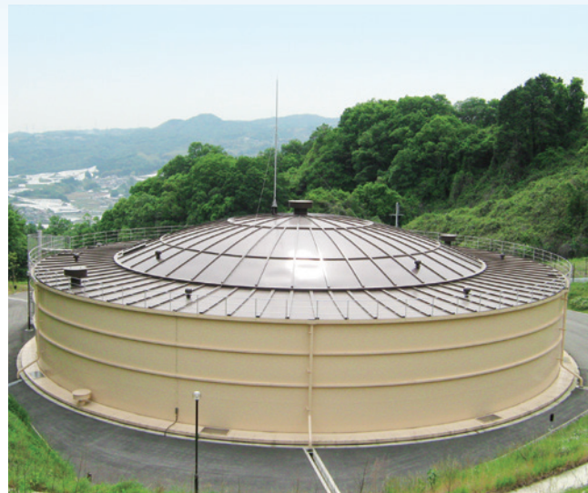
奈良県水道局 殿 容量：11,500m 3 直径：38.7m 高さ：10.0m
