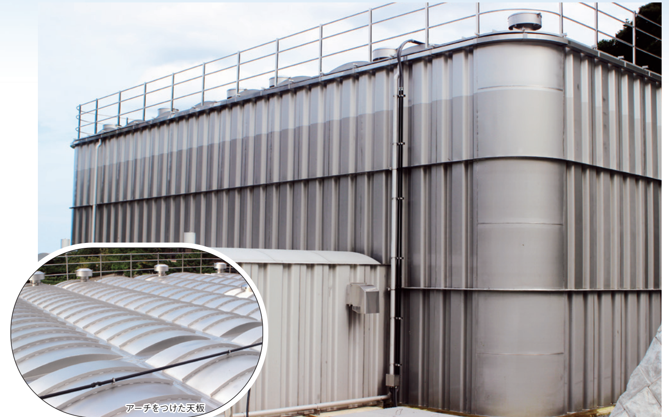
熱海市公営企業部 殿 容量：1,900m 3 寸法：18.6m×18.6m 高さ：6.5m(SUS)
