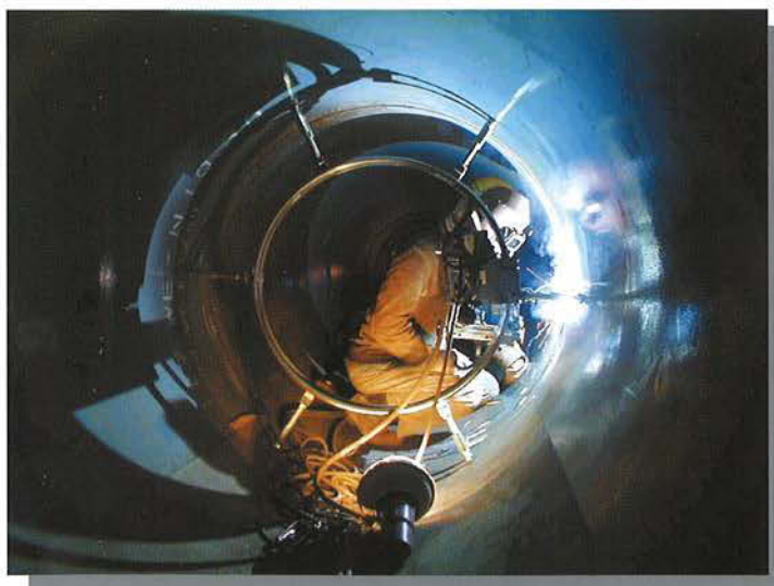
1250A溶接作業
