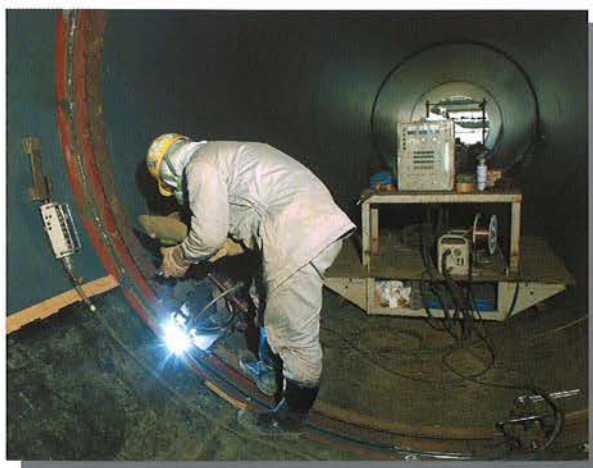
3000A溶接作業
