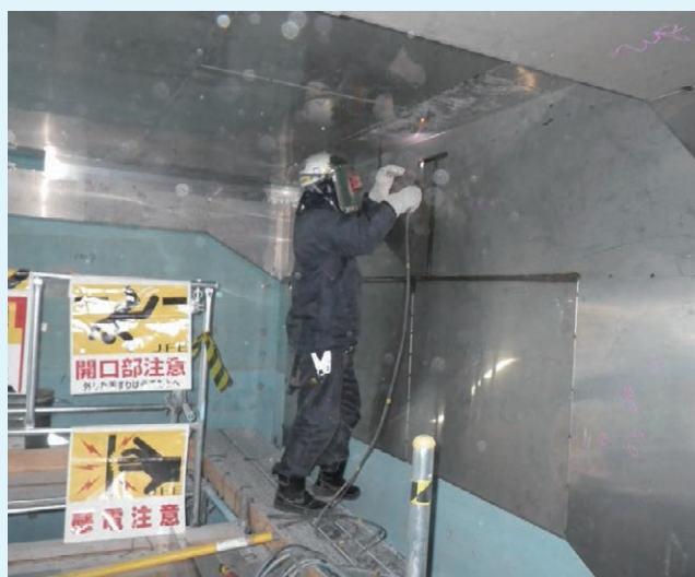
内張り溶接状況
