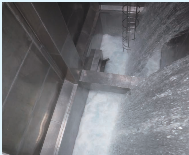
充水確認作業
