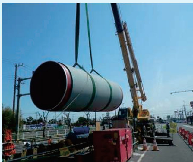
吊り込み状況
