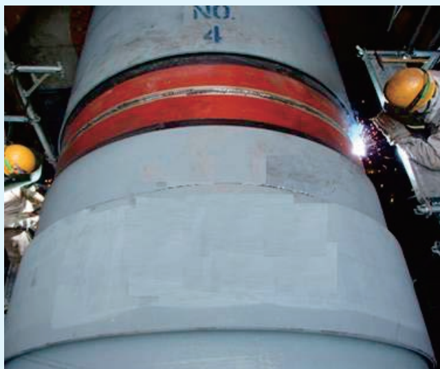
外面溶接状況
