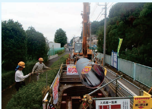
鋼管搬入・吊り込み状況
