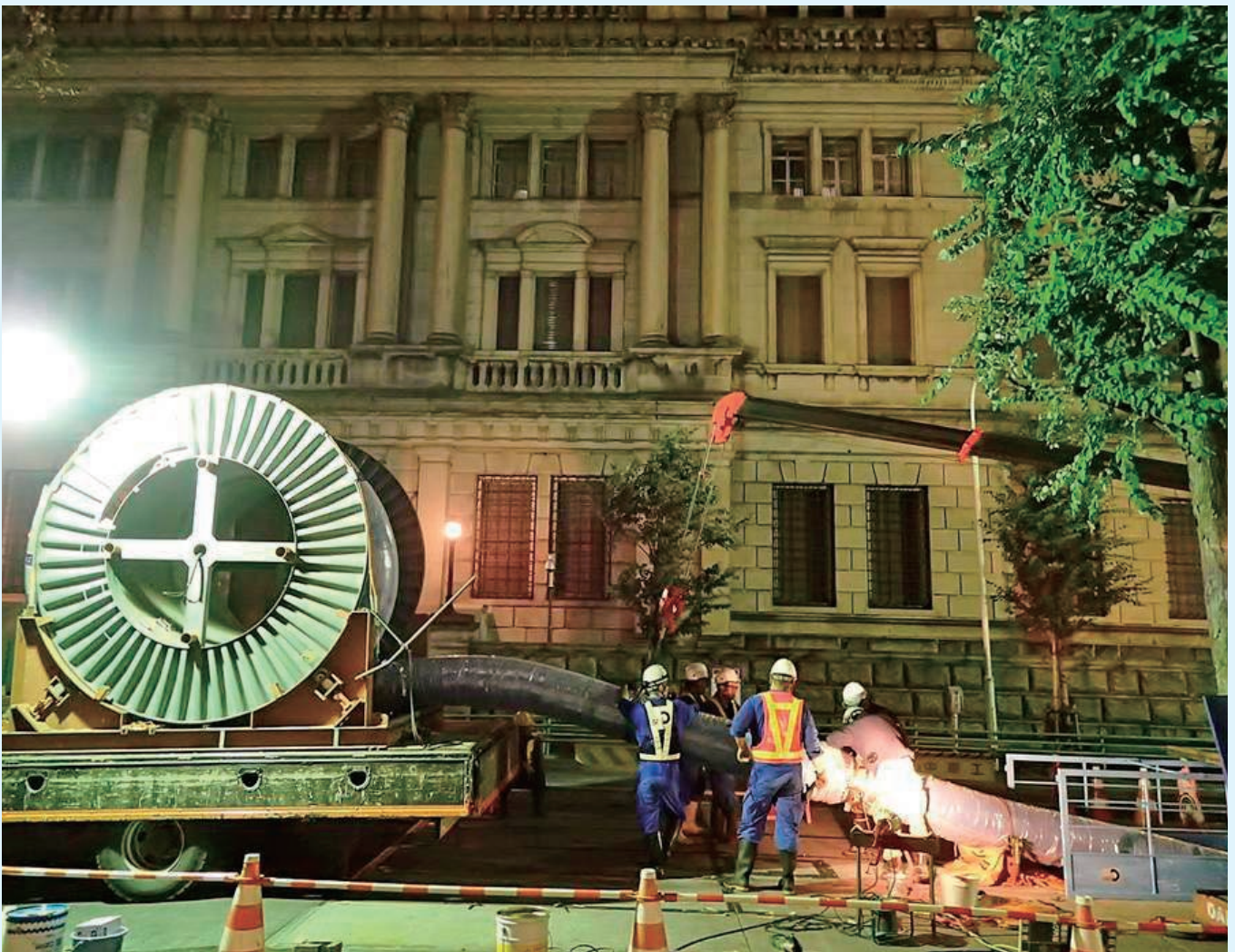
日本銀行本店前の発進立坑 —SDF管の溶接作業状況—
