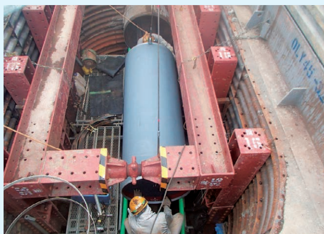
鋼管搬入・吊り込み状況
