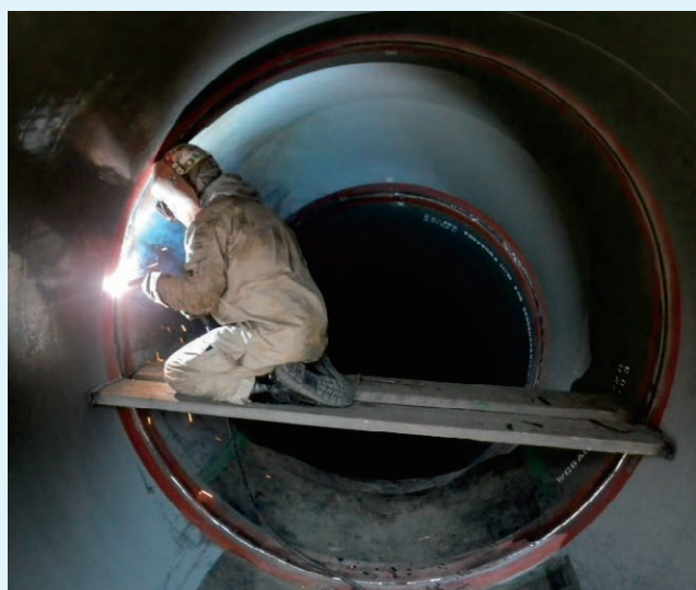
内面溶接状況
