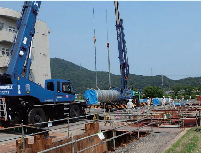
吊り込み状況
