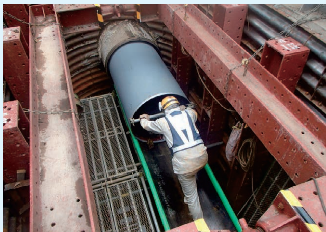
既設管内運搬状況
