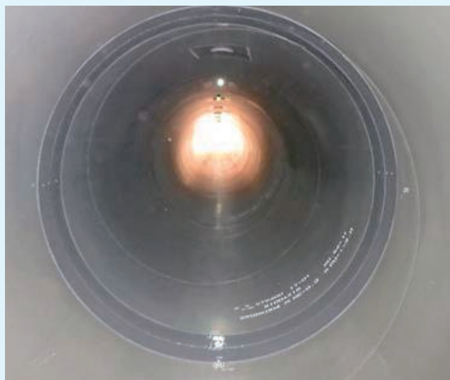
内面塗装完了
