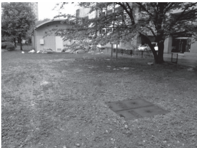
写真1 熊本市中央区 白川公園敷地内 耐震性貯水槽（100m 3 ）
