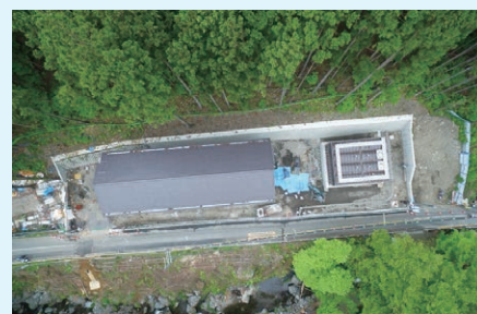
大丹波浄水所上空写真
