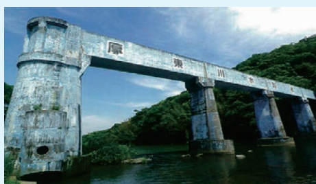
昭和19年建設の水路橋
