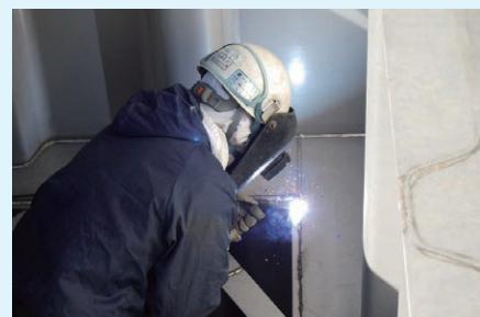
中間補強帯部溶接状況
