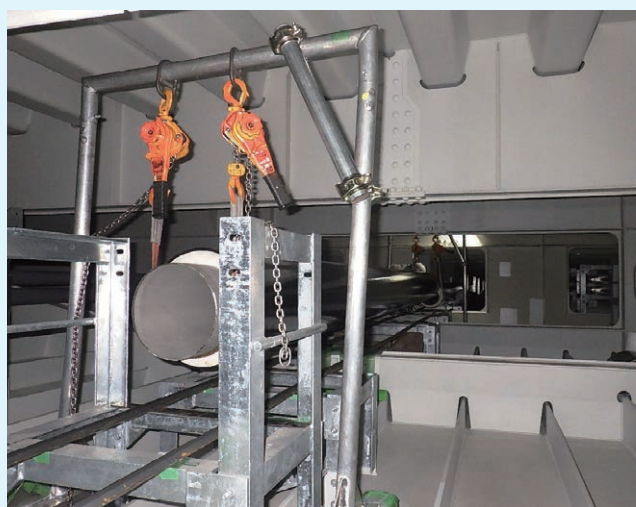
添架管据付状況
