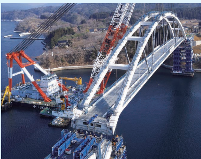
大島架橋架設状況
