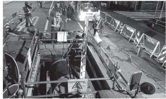
台東区でのPIP工法施工のようす
