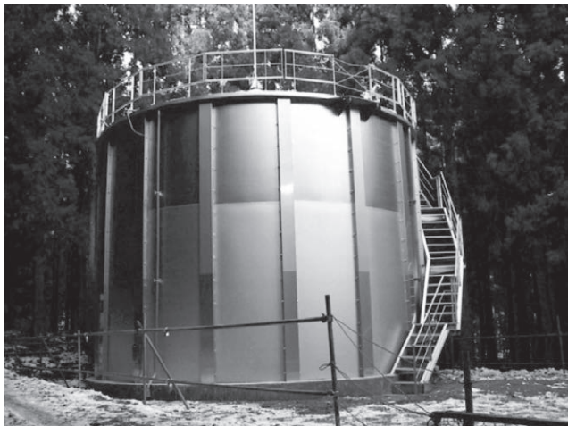
写真1 ステンレス鋼製配水池 (有効容量350m 3 )
