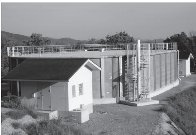
写真2 ステンレス鋼製配水池（小判形） (有効容量1,500m 3 )
