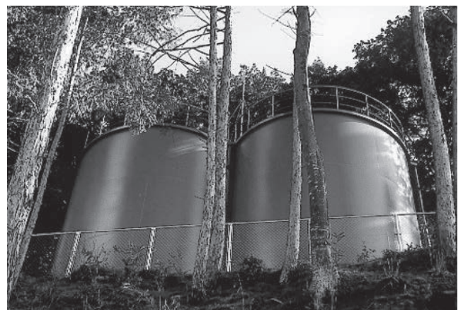
写真4 鋼製配水池（めがね形2槽） (有効容量125m 3 +125m 3 )
