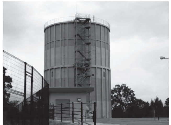
写真3 ステンレス鋼製配水池（上下2槽） (有効容量3,000m 3 +3,000m 3 )
