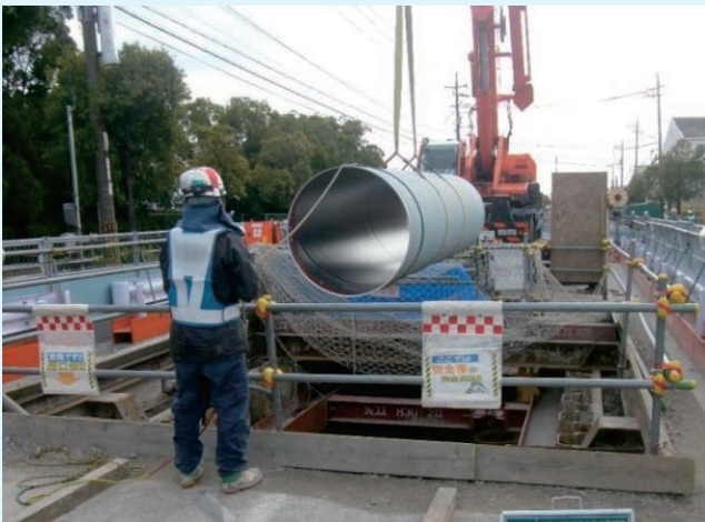
吊り込み状況
