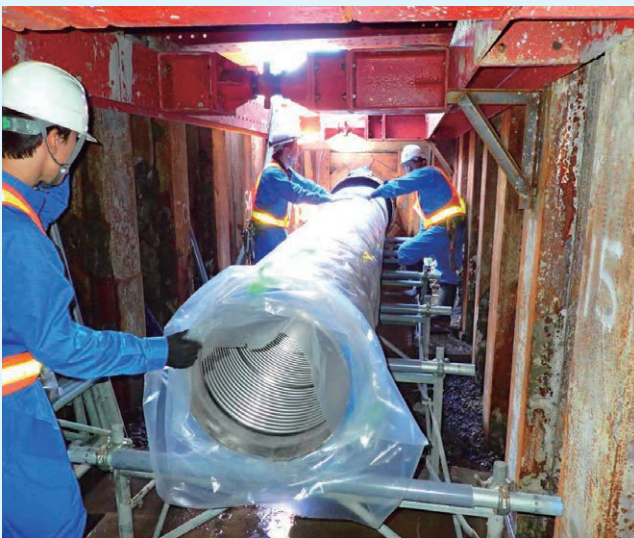
立坑内での作業状況
