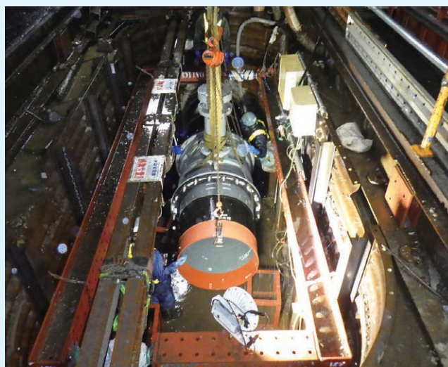
バルブ据付状況
