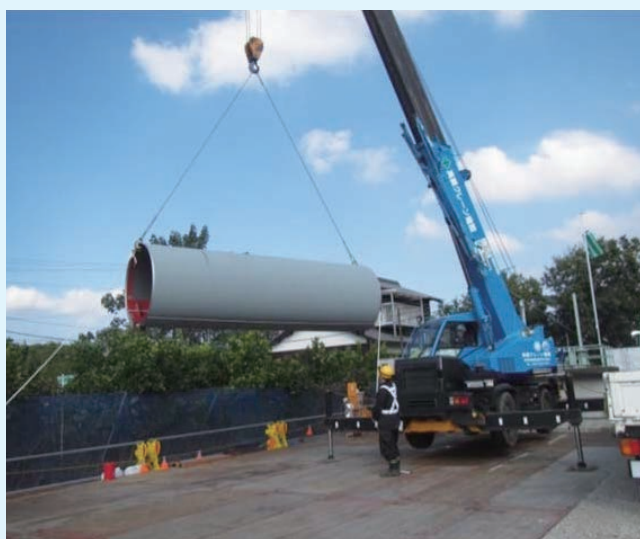
鋼管搬入状況（香東川サイホン改修工事）
