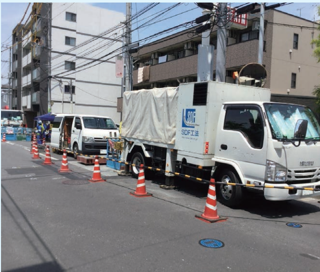
開削工事が不可能な狭い道路での施工
