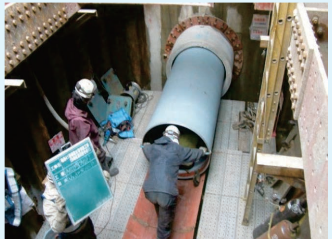
鋼管挿入状況
