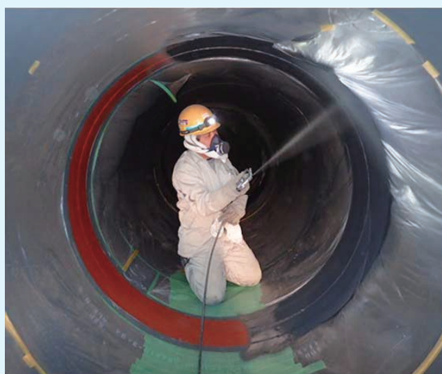
内面塗装状況（第7工区袖尾サイホン他改修工事）
