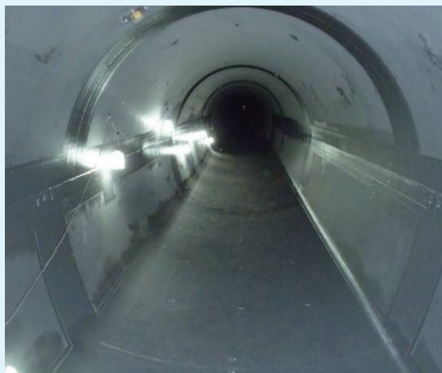
施工完了（第4工区糠山サイホン他改修工事）
