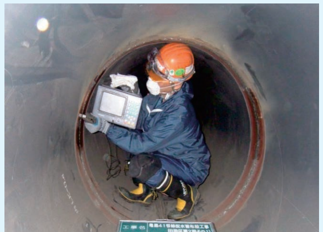
溶接部検査状況
