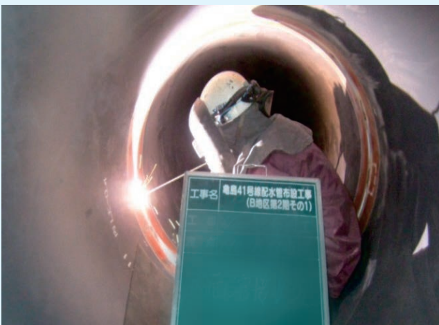
鋼管溶接状況
