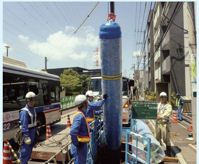
引込み作業の状況
