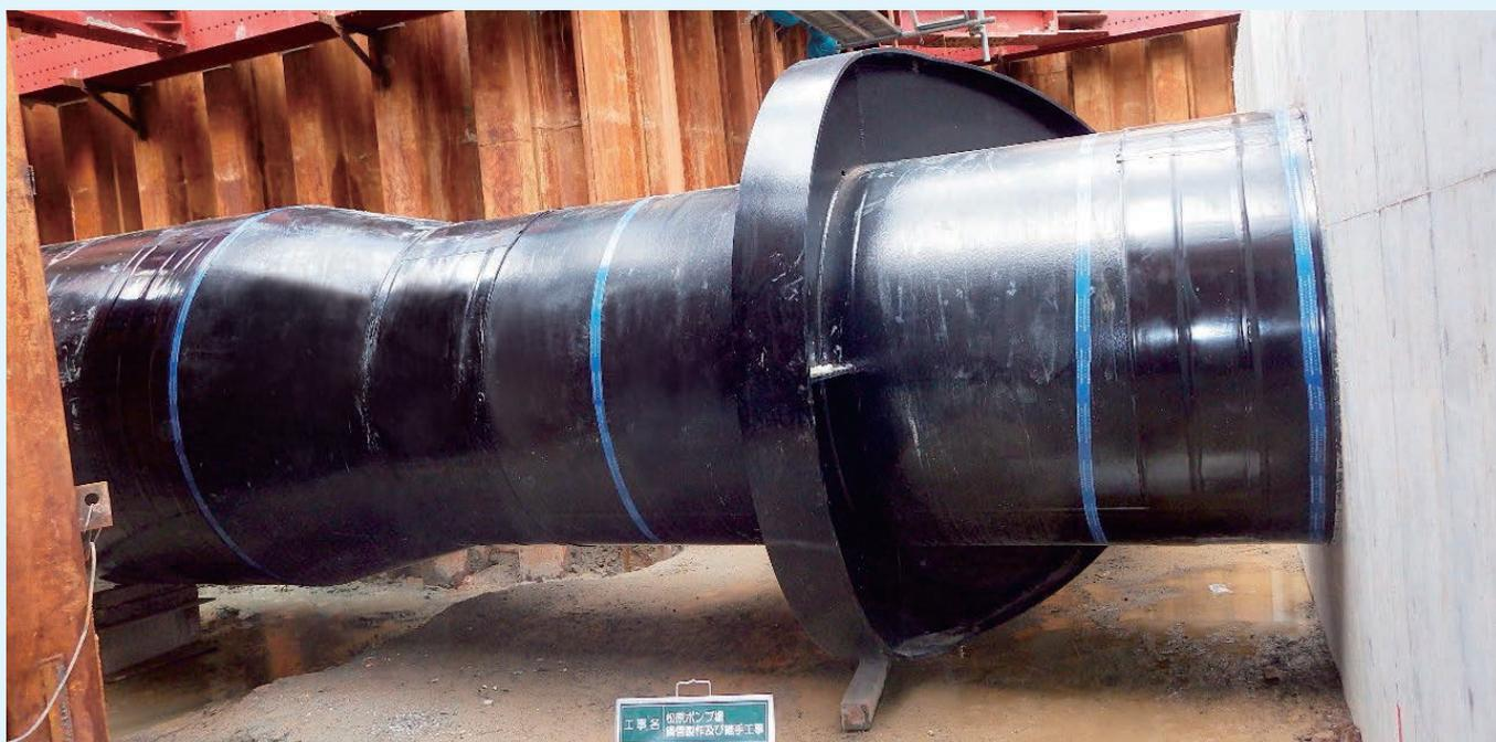
据付け状況（口径1600A 補剛付T字管部）
