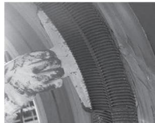
くし形へら、ゴムへらをビード(溶接部)に直角方向に動かします。
