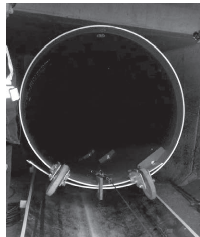
写真-2 巻き込み鋼管によるPIP工法
