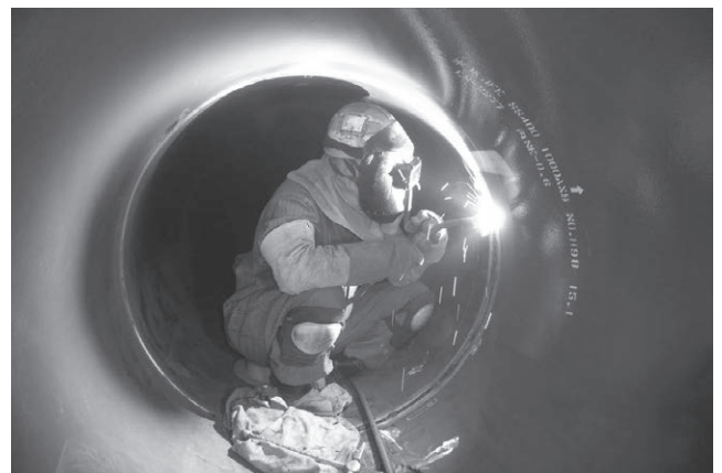
写真－6 溶接状況
