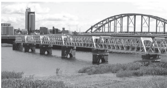
写真1 本庄水管橋全景
