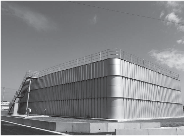
写真3 ステンレス鋼製角形配水池 (3,200m 3 )
