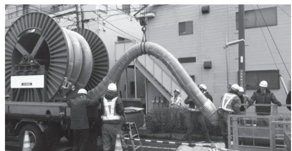
写真3 SDF工法の引込み施工状況
