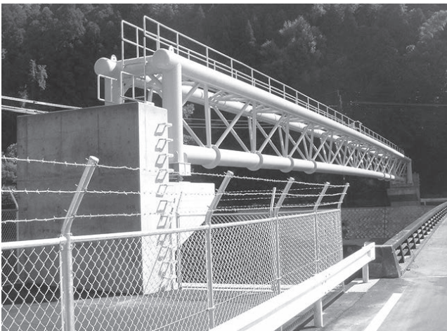
写真3 三角トラス補剛形式
