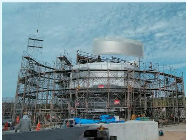
柱脚4段目吊込み状況
