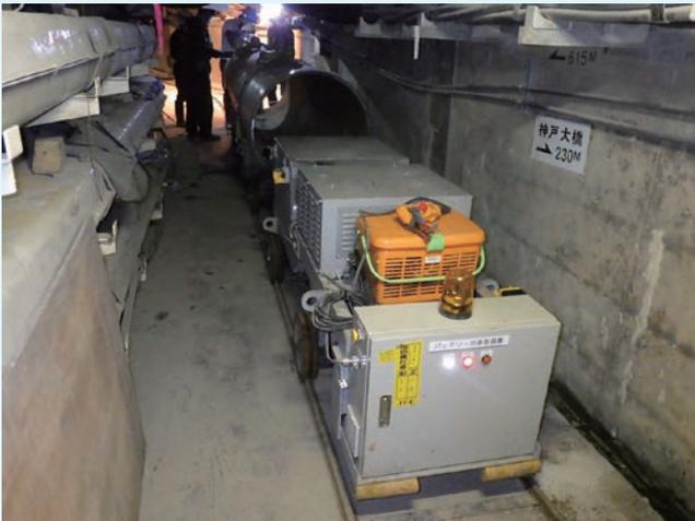
バッテリー台車による鋼管搬入
