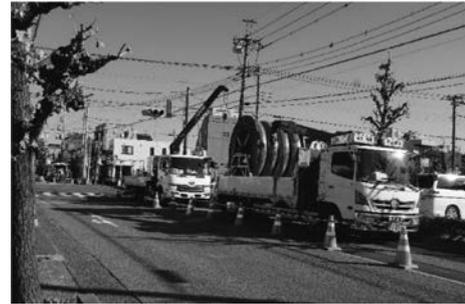
写真-2 引込み施工状況（発進立坑部）
