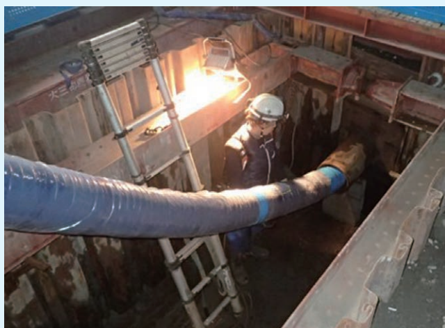
引込み作業の状況
