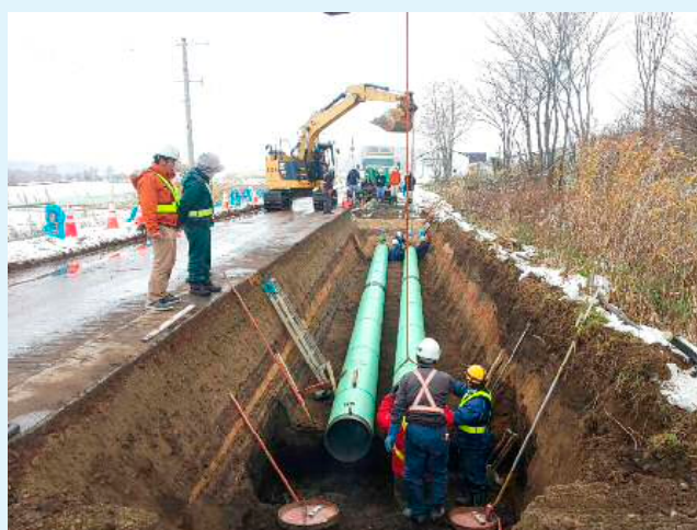
18,000L管での吊り込み作業
