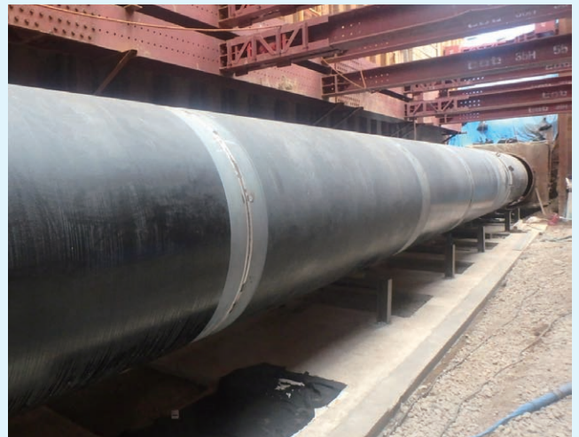
溶接完了状況
