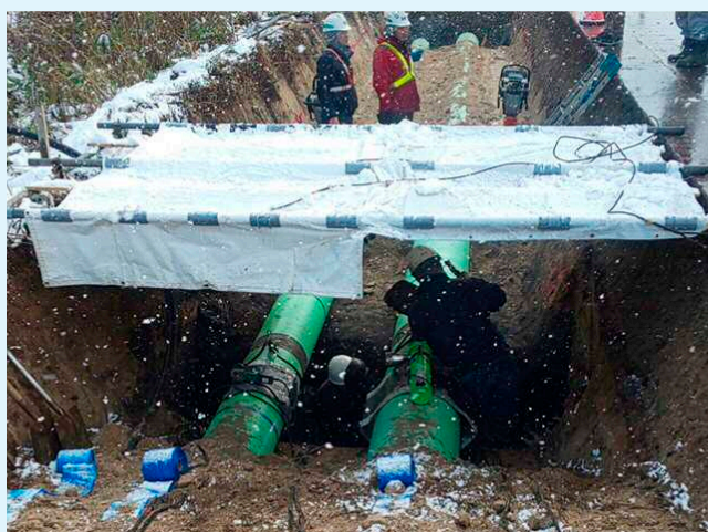
防雪対策下での溶接作業
