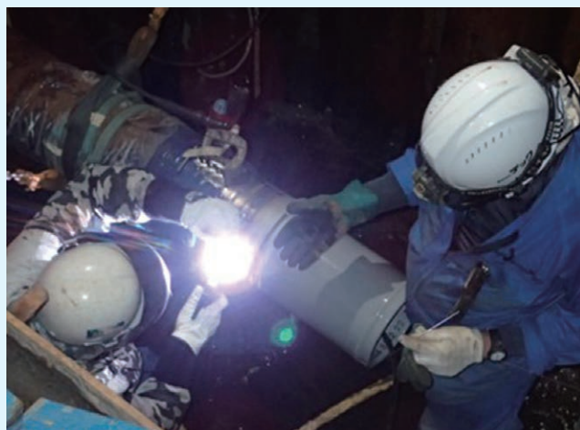
継手の溶接状況
