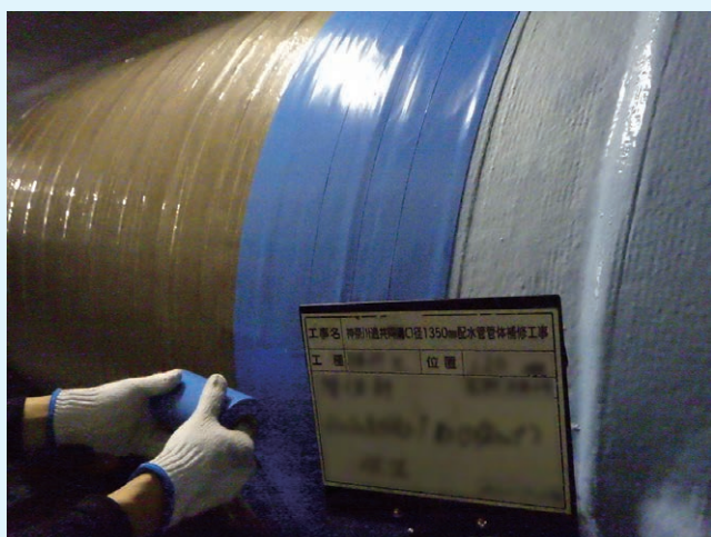
ブチル系防食テープ巻き状況
