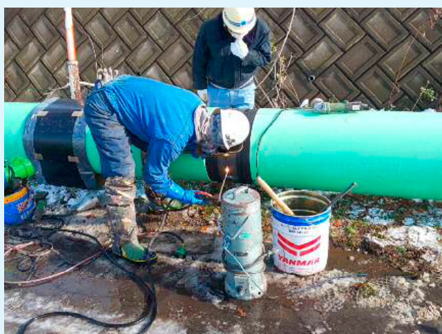
9,000L+9,000Lの陸付け作業
