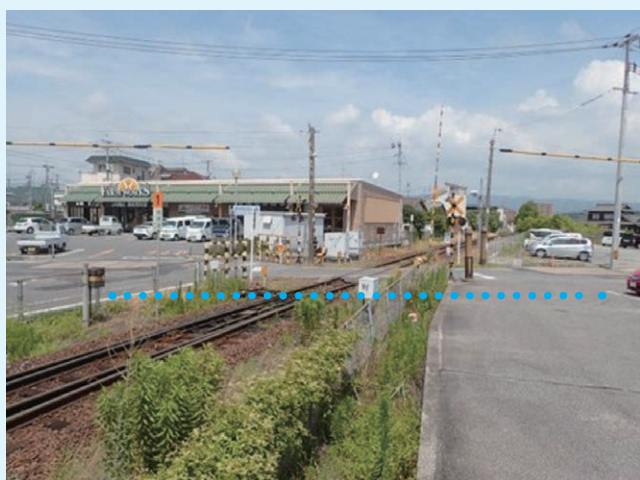
開削工事が不可能な軌道横断箇所での施工
