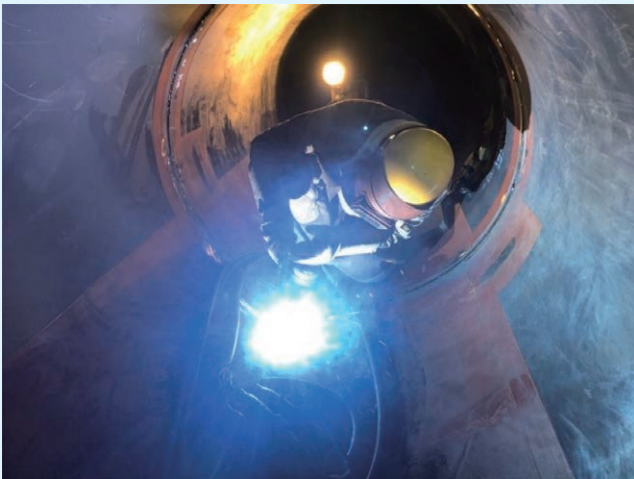
内面溶接（巻込鋼管）
