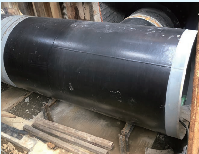
既設管接続状況
