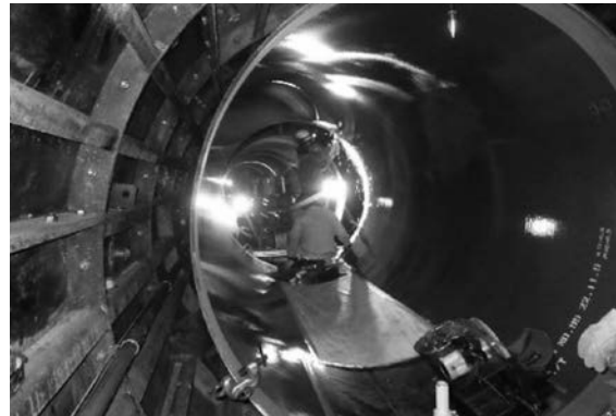
東村山境線(仮称)4工区トンネル内配管(鋼管)作業写真
