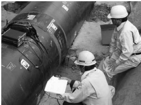
写真－3 絶縁抵抗試験状況
