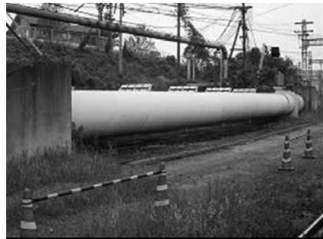
写真-2 水管橋暴露試験開始時
