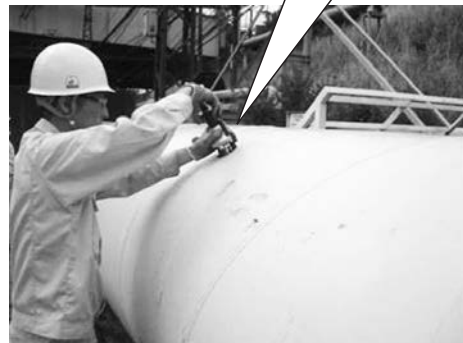
写真－5 アドヒージョン測定状況
