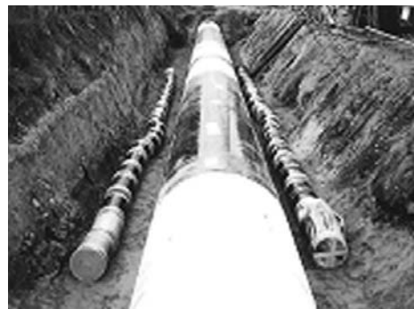
写真-1 鋼管路埋設試験開始時
