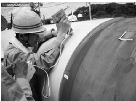
写真－4 色差測定状況
