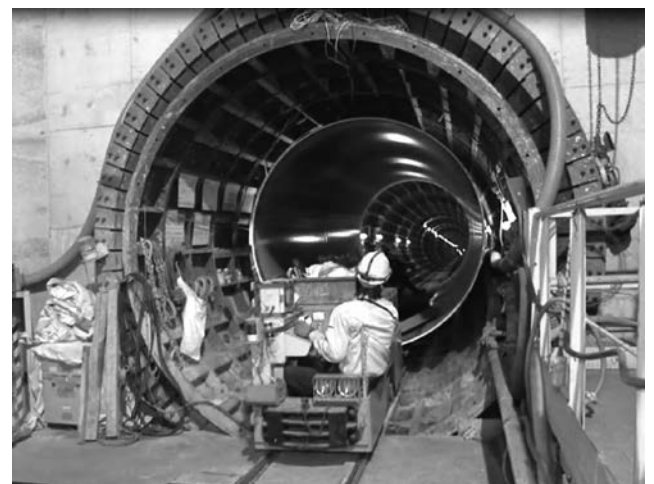
写真-2 鋼管搬入
