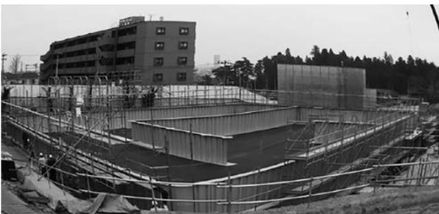
写真-4 アニチュラPL+側板・導流壁1段目設置
