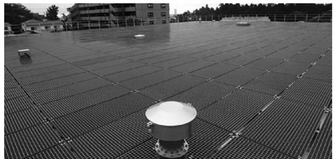
写真-9 付帯設備設置 (通風筒、歩廊等)
