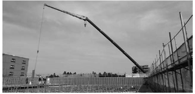
写真-6 側板・導流壁2段目、ブレース材設置
