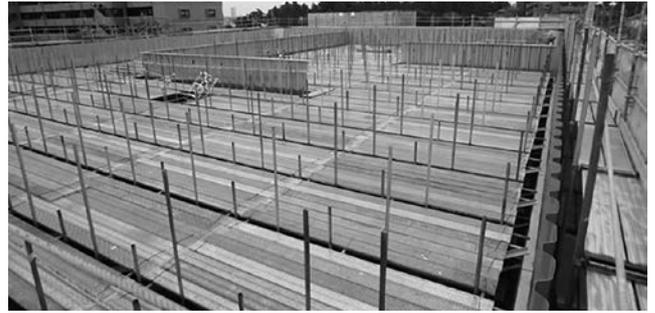
写真-7 側板・導流壁3段目、ブレース材設置
