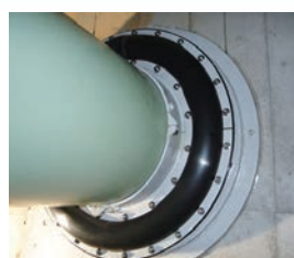
配管貫通孔止水装置
