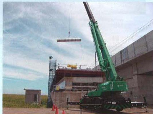
ステンレス鋼管の橋上吊上げ状況
