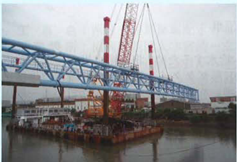
450トン起重機船による一括架設方式で施工
