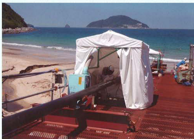
陸上ステージでの溶接状況(φ150SUS鋼管)
