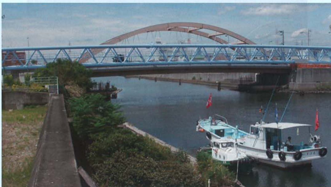
完成した水管橋全景(トラス補剛形式)
