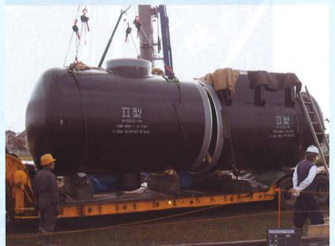
貯水タンクを二分割で搬入し、 現場にて溶接接合して一体化する
