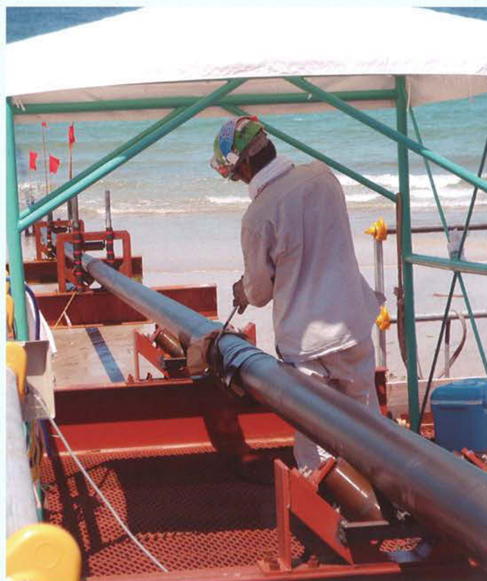
陸上ステージでの外面塗覆装状況(φ150SUS鋼管)
