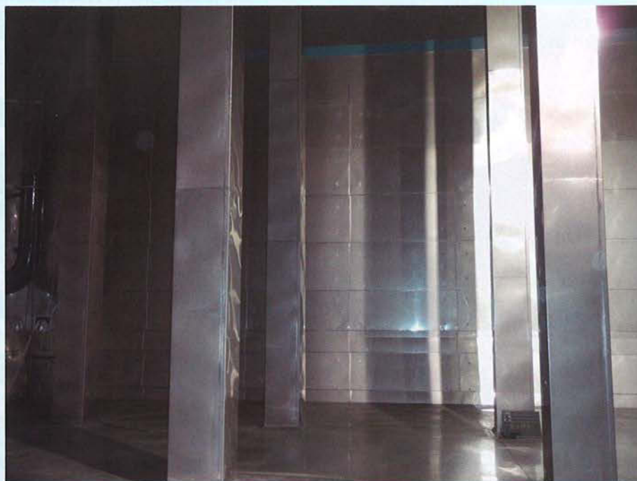
ステンレス鋼板内張り工法で施工
