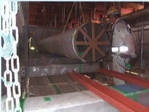
ステンレス鋼管の吊込み状況
