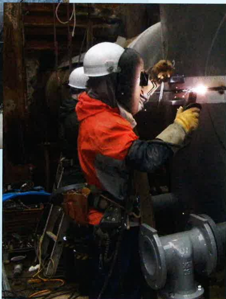
割丁字管取付溶接状況
