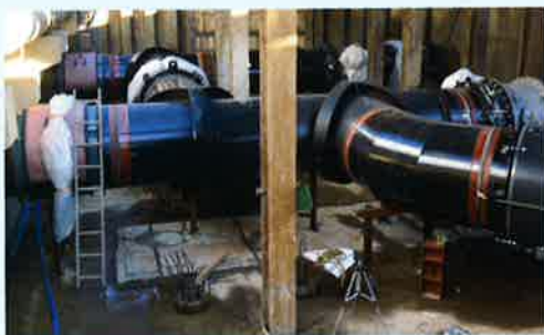
口径1350mm (既設管との接続)
