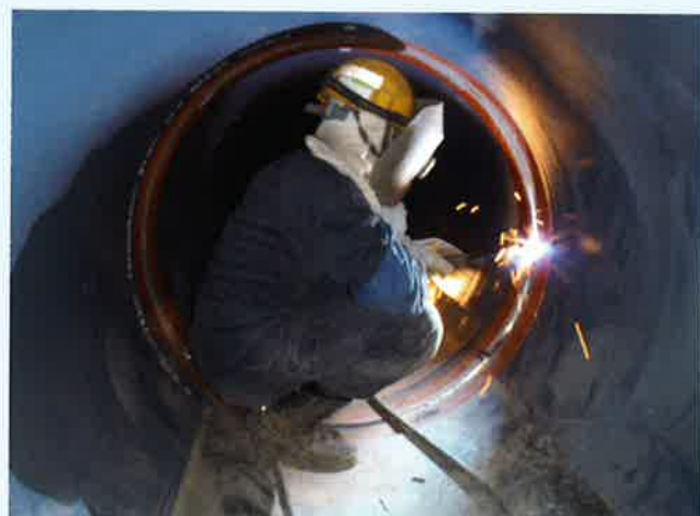
鋼管溶接状況
