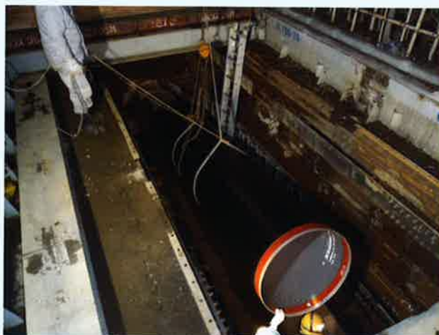
鋼管挿入状況
