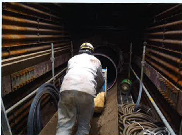
鋼管搬入状況
