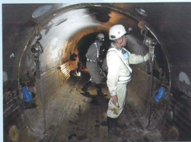
軸方向および周方向を溶接
