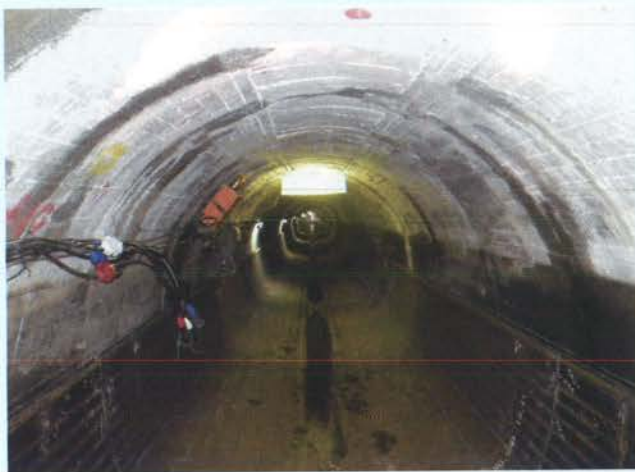
戸室隧道内（施工前）
