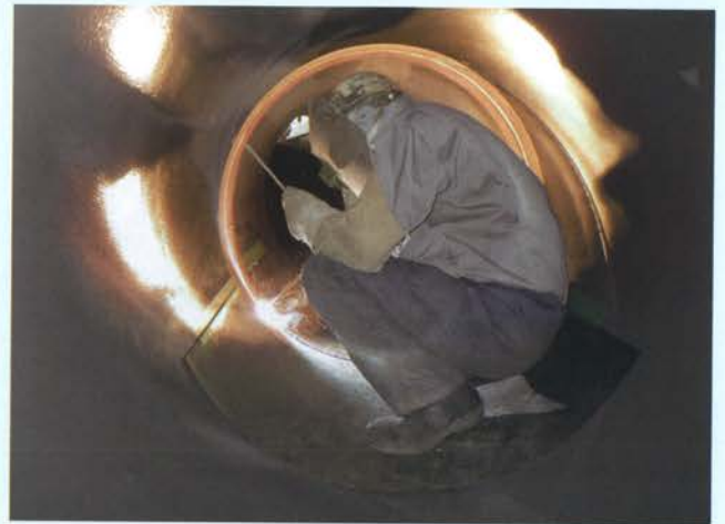
鋼管内面溶接状況
