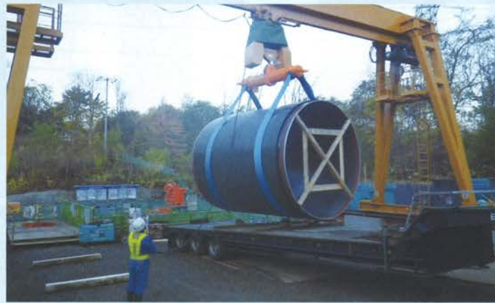
推進用鋼管 (φ3000) の吊込み状況
