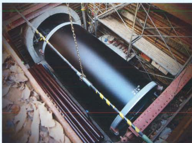
既設暗渠 挿入状況
