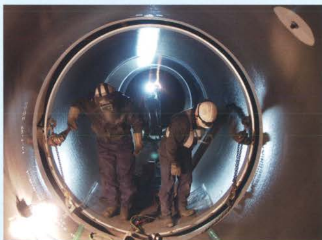
鋼管据付状況
