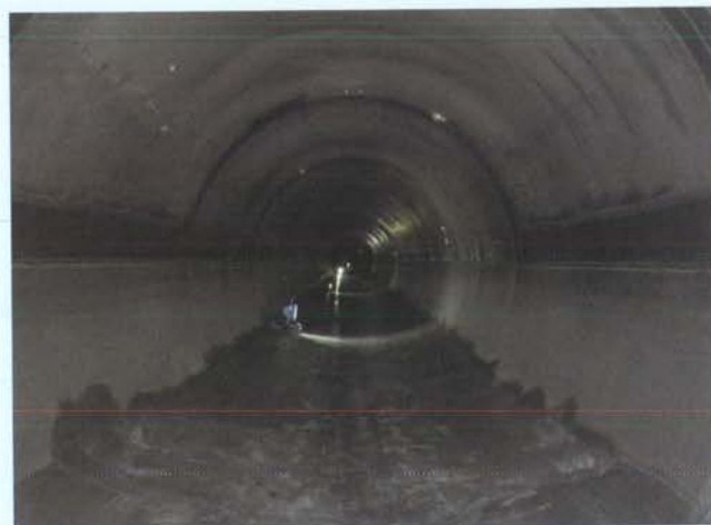
鋼板を内側に設置（施工後）
