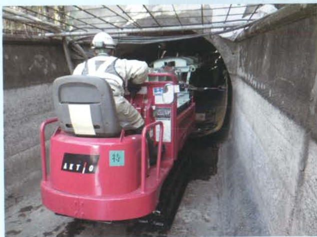
上下分割で製作した鋼板を坑内に搬入
