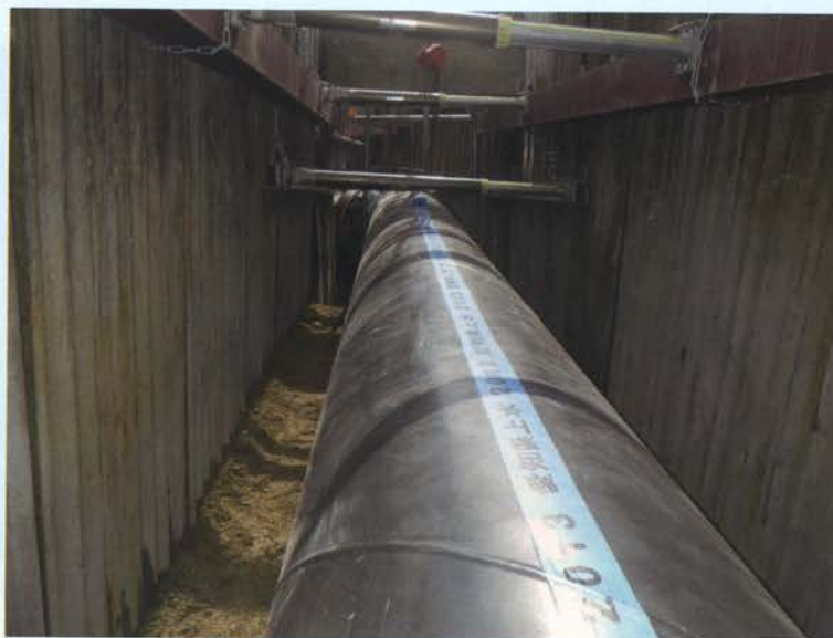
鋼管布設完了
