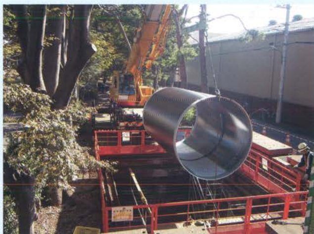
立坑内 搬入状況
