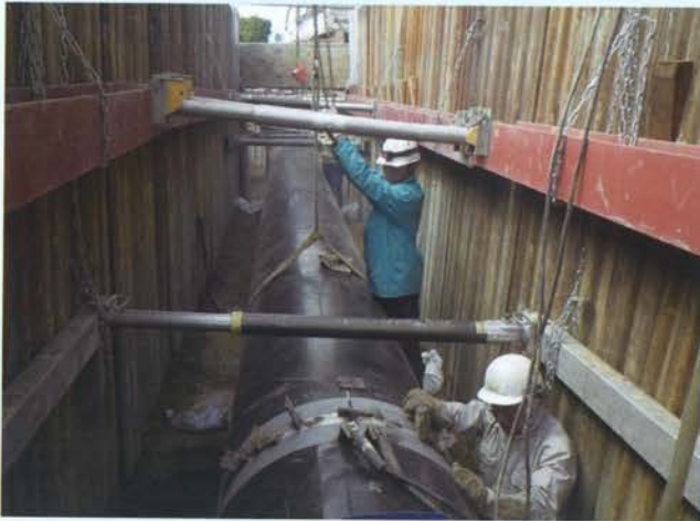
鋼管布設状況
