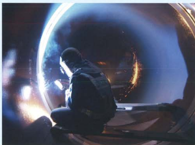
鋼管溶接状況
