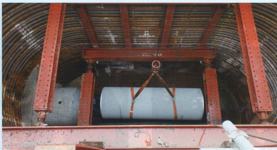
鋼管搬入状況
