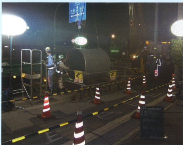
吊り込み状況
