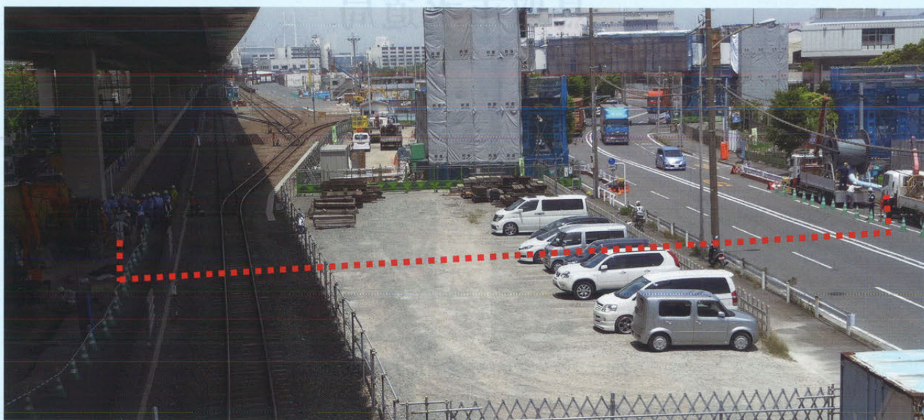
軌道を遮断せず昼間の施工が可能
