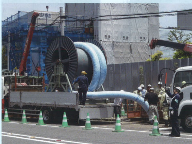
引込み作業の状況
