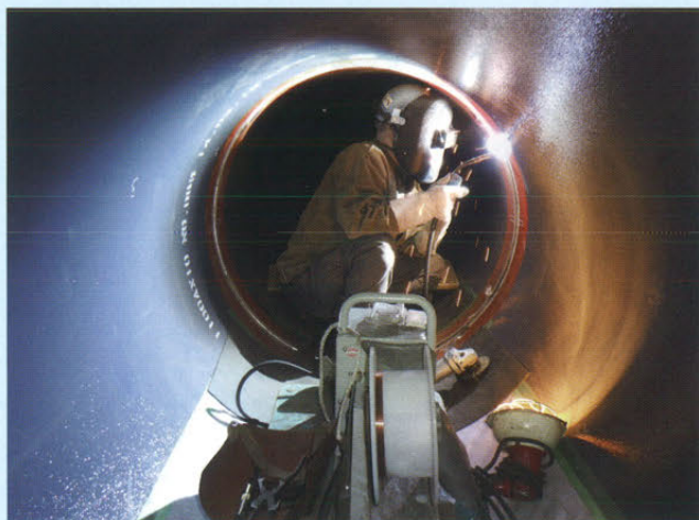
鋼管溶接状況
