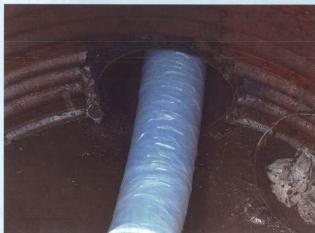
SDF管の既設管への挿入状況
