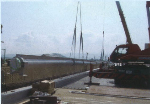
25tラフタークレーン 2 台による相吊架設
