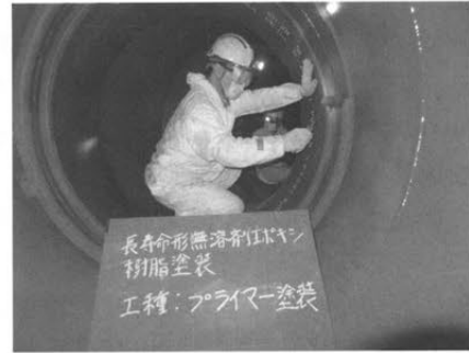
②ローラーによる現場プライマー塗装
