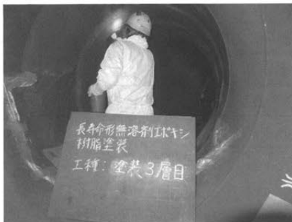
⑤R加工ゴムへらによる3層目塗装
