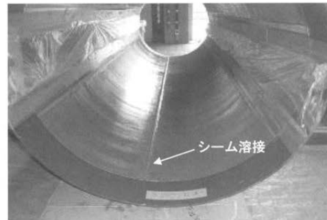
写真6 塗装仕上り状況
