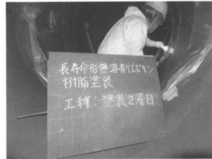
④R加工ゴムへらによる2層目塗装
