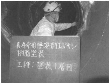
③R加工くし形へらによる1層目の塗装
