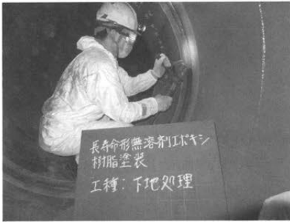
①ロータリーブラスターによる下地処理
