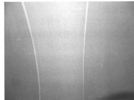
⑥塗装完了後の外観
