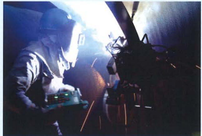
自動溶接状況
