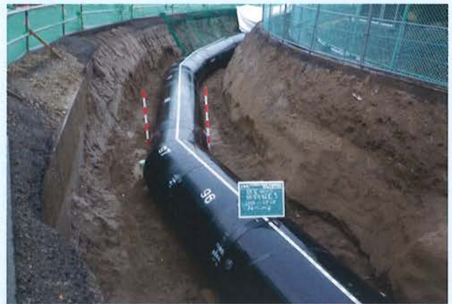
5工区布設完了状況
