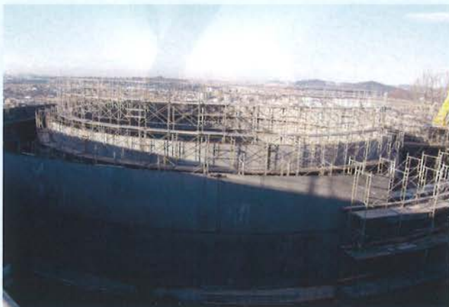
配水池組立状況
