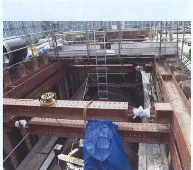
貯水槽設置状況
