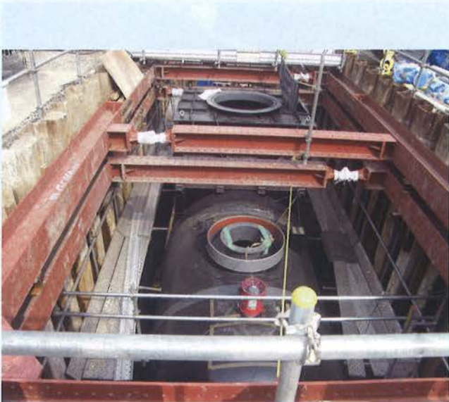
貯水槽設置状況
