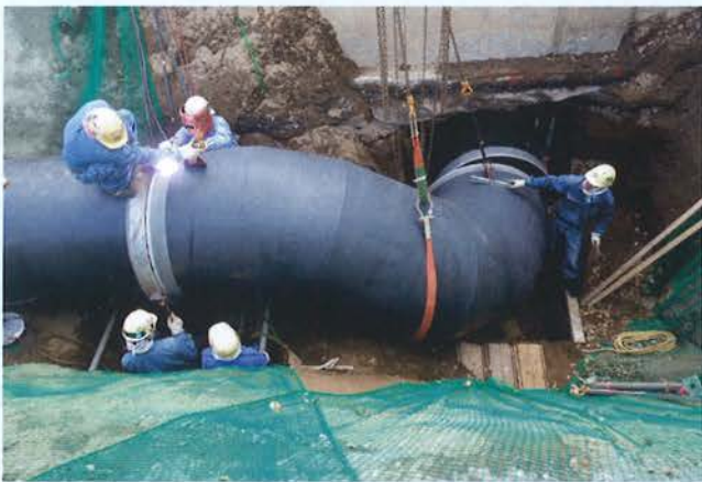
5工区水路伏せ越し状況
