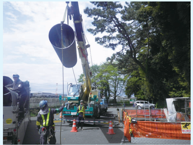
吊り込み状況
