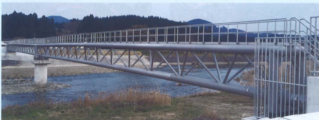
完成した水管橋全景
