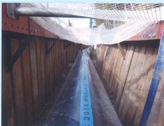
一般部 鋼管布設完了状況
