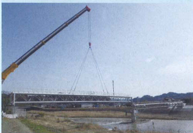
右岸側架設状況
