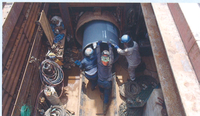
押し込み状況
