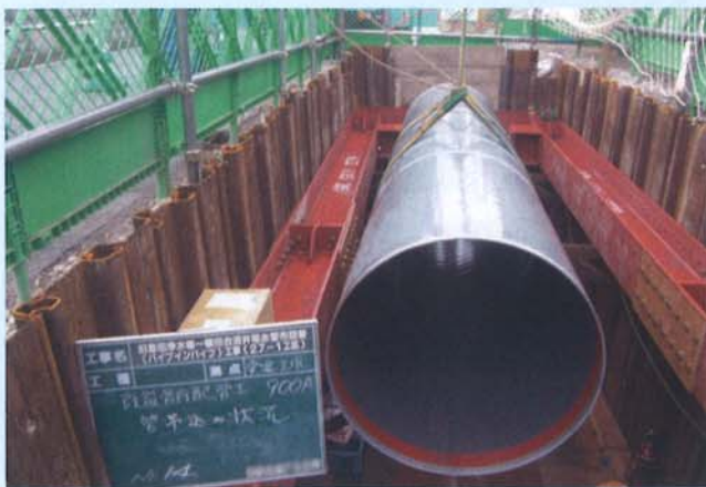
吊り込み状況
