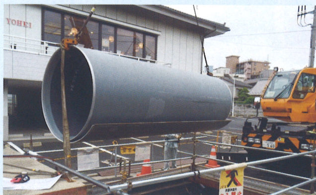
吊り上げ状況
