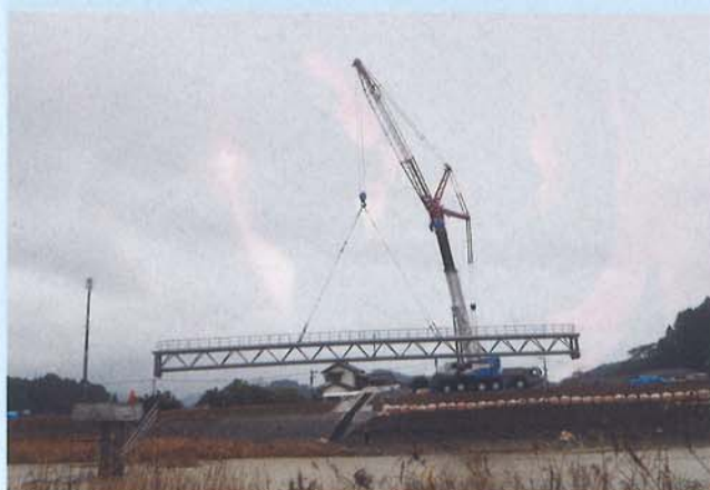
左岸側架設状況
