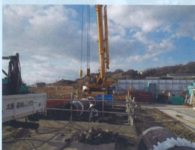
推進部 鋼管吊卸状況
