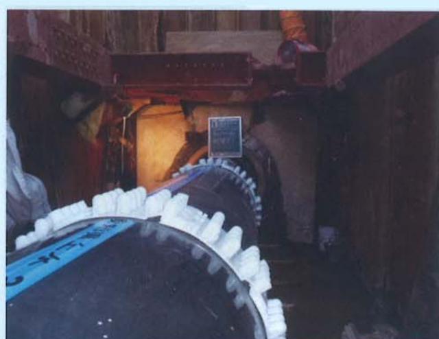
推進部 鋼管挿入状況
