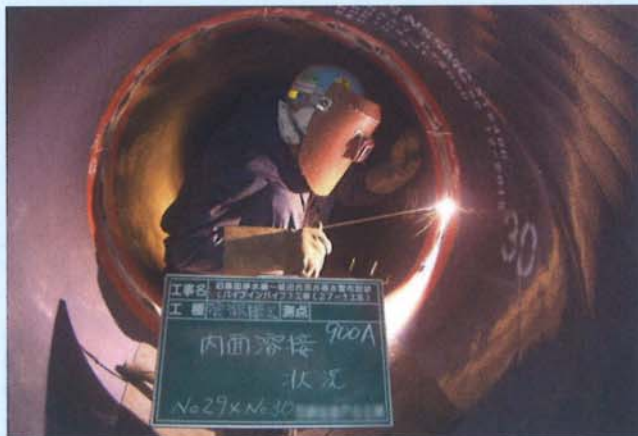
内面溶接状況
