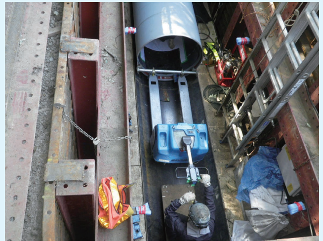
巻込み鋼管挿入状況
