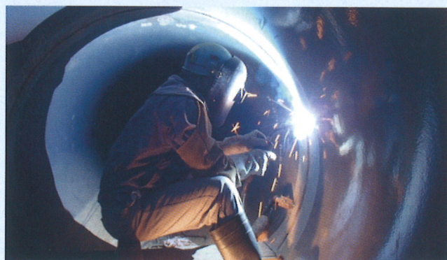
溶接作業状況
