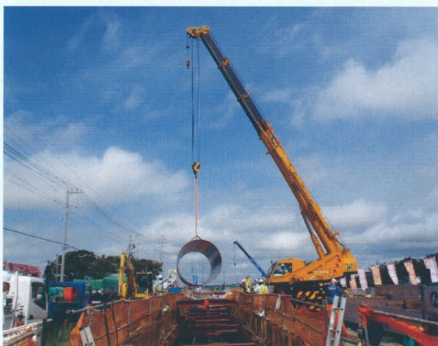
吊り込み状況
