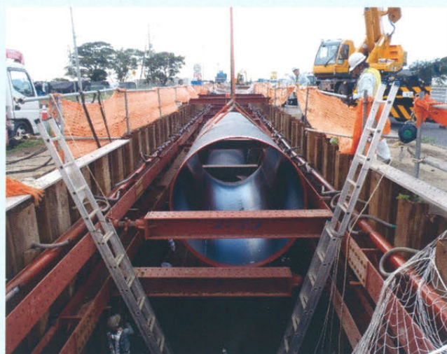
吊り込み状況
