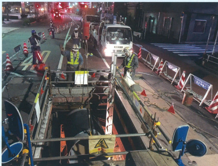
鋼管吊り込み状況
