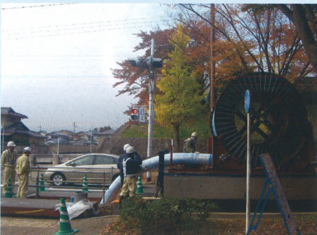
SDF管の引込み状況【発進立坑】
