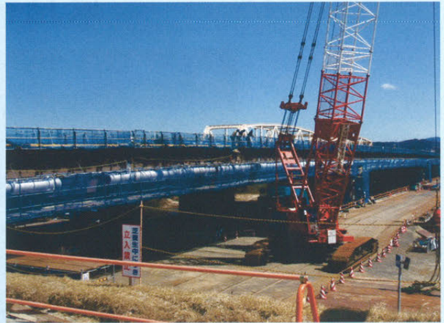
高橋添架管施工状況
