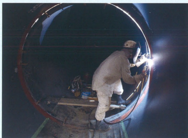
管内溶接状況
