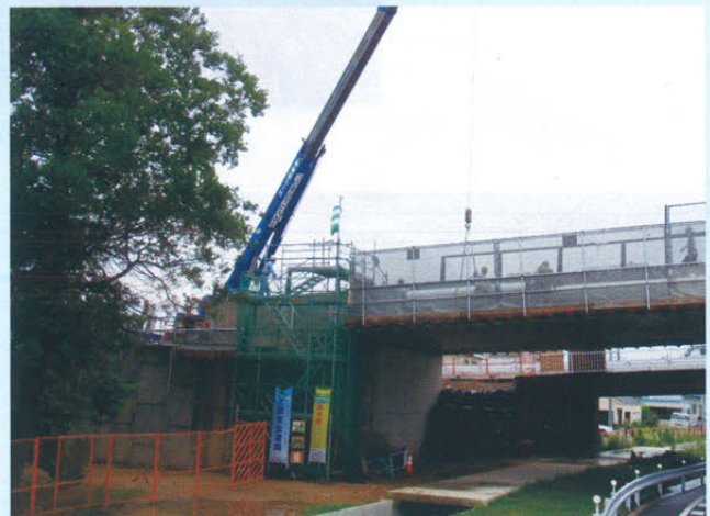
安永川橋添架管施工状況
