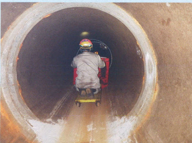
既設管内運搬状況
