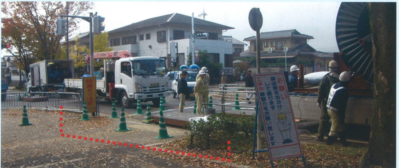
車線規制により昼間の施工が可能
