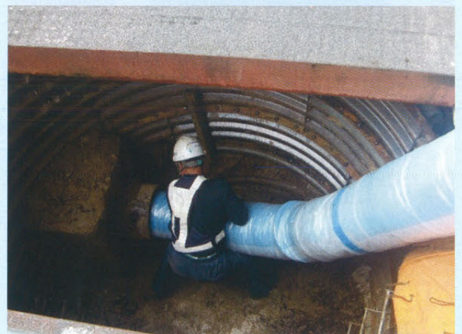
SDF管の引込み状況【発進立坑】
