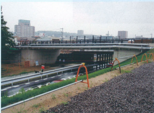
安永川橋添架管完成全景
