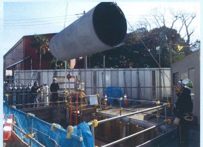
吊り込み状況
