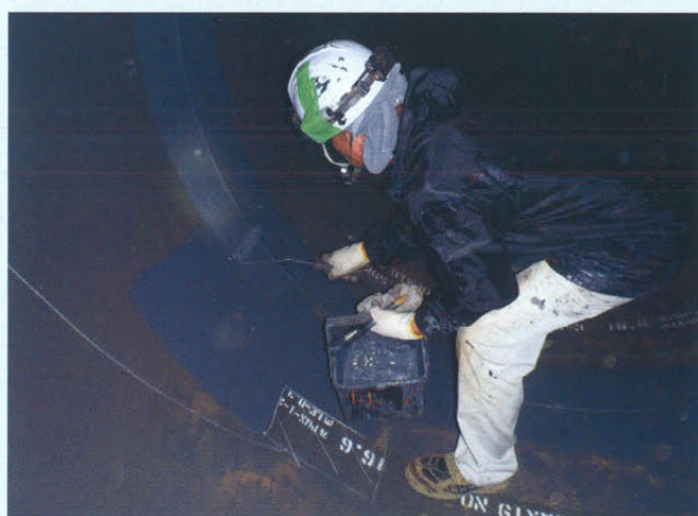
内面塗装状況
