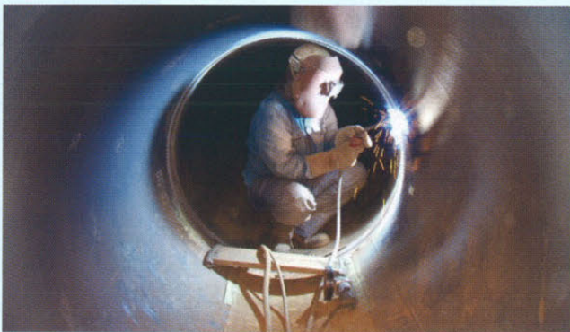
新設管溶接状況
