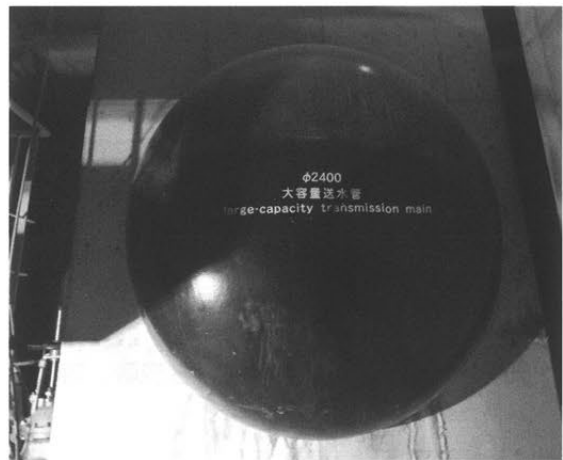
大容量送水管
