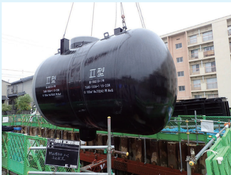
貯水槽の吊込状況
