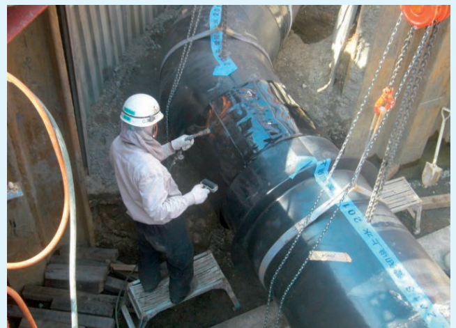
鋼管布設（外面塗装：ジョイントコート）状況
