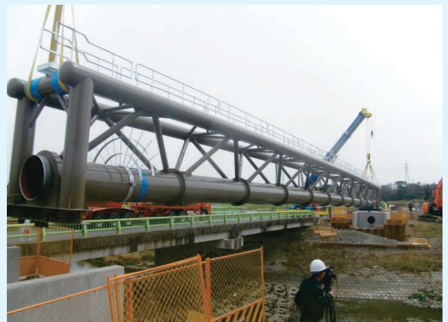
水管橋架設状況
