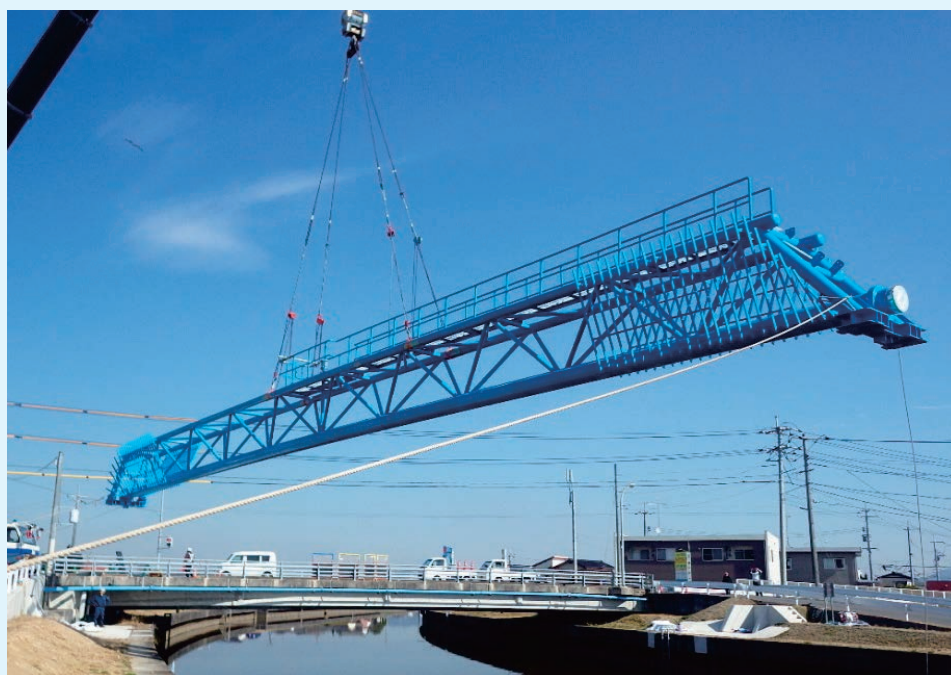
水管橋架設状況
