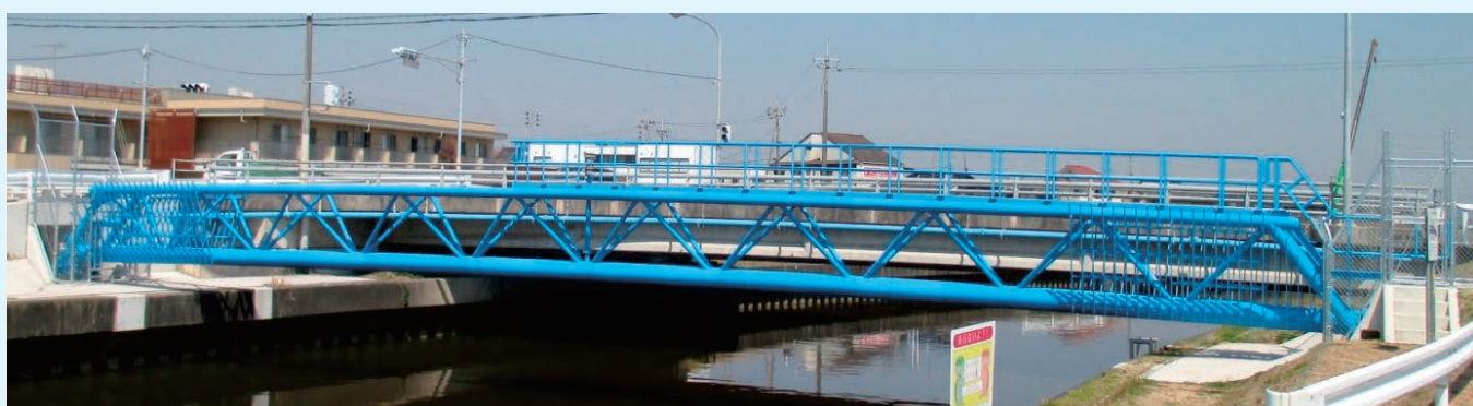
水管橋架設完了
