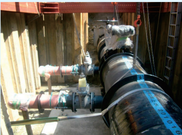
鋼管布設完了
