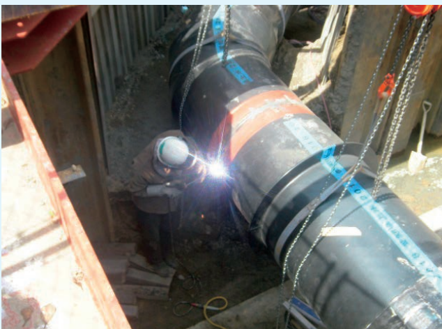
鋼管布設（溶接）状況
