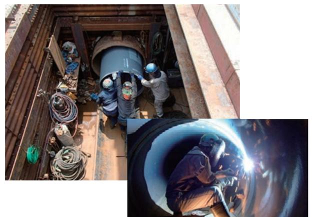
▲更新の時代となり、PIP工法の需要が高まってきました。97号（平成28年6月）では、内径1350mm鋼管溶接作業を紹介しています。
