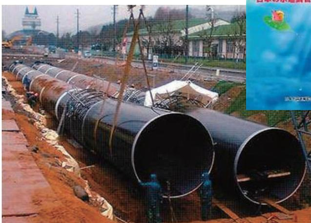
▲鋼管は農業用水事業でも採用され、73号（平成16年6月）に九頭竜川の開水路に鋼管を布設した送水システムの再構築を行った写真を掲載しています
