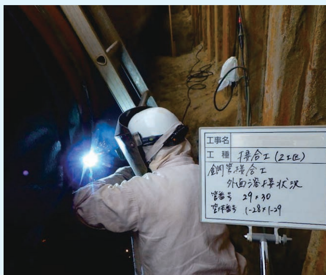
外面溶接状況
