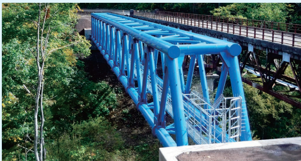
水管橋架設完了
