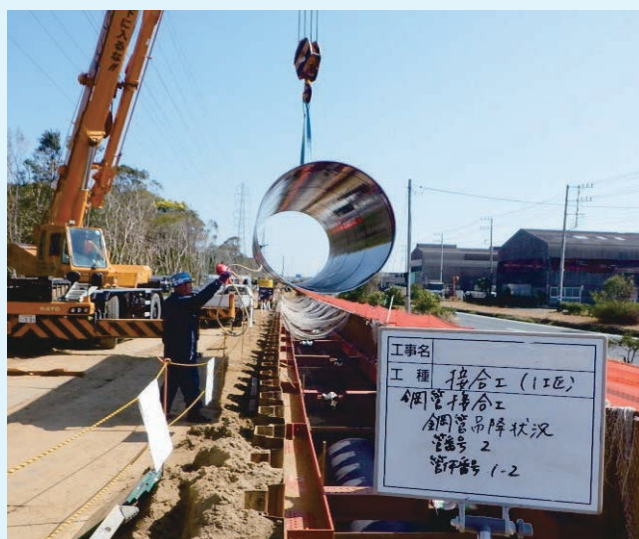
吊り込み状況
