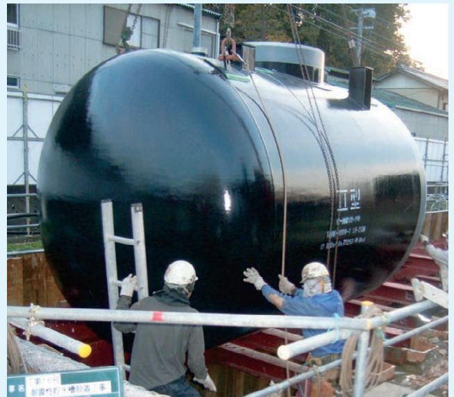
吊込据付状況
