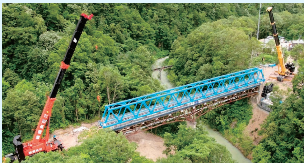
水管橋架設状況
