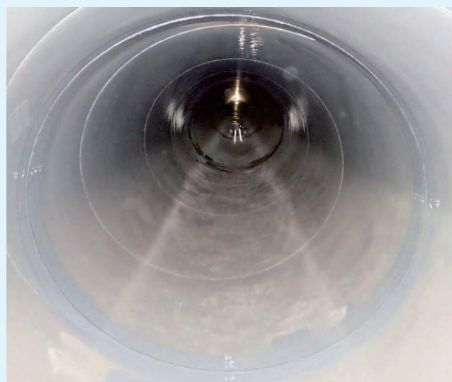
内面塗装完了
