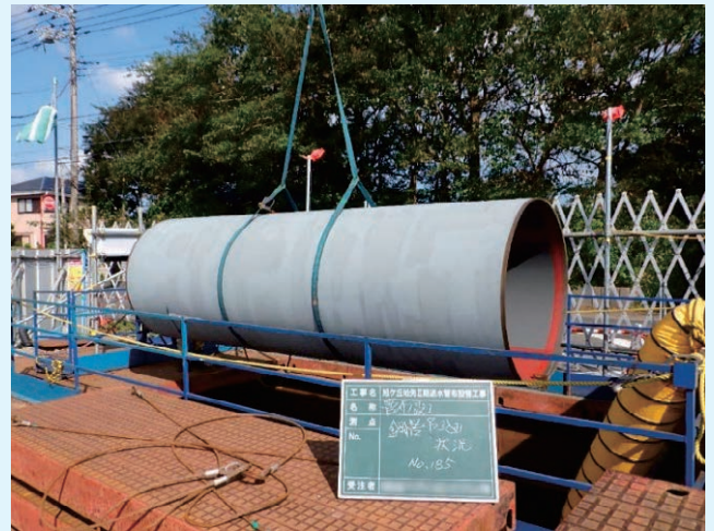
鋼管搬入・吊り込み状況
