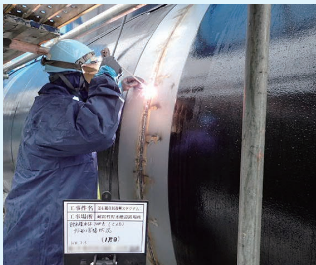
本体外面溶接
