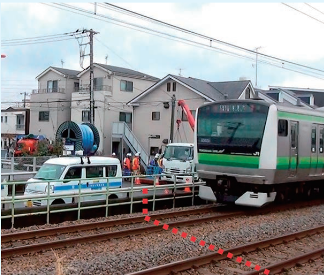
開削工事が不可能な軌道横断箇所での施工
