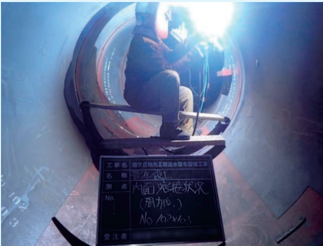
内面溶接状況
