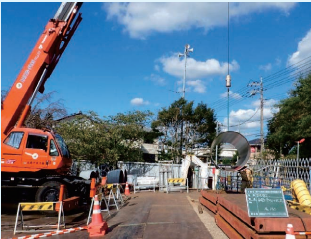
鋼管搬入・吊り込み状況
