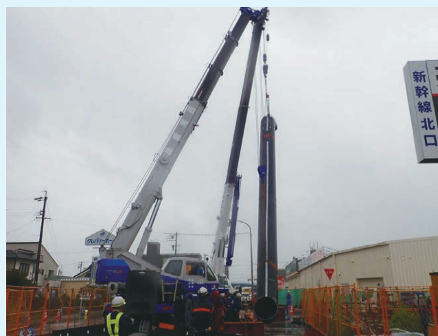
立坑部 鋼管吊り下し状況
