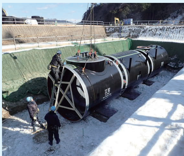
吊込据付状況
