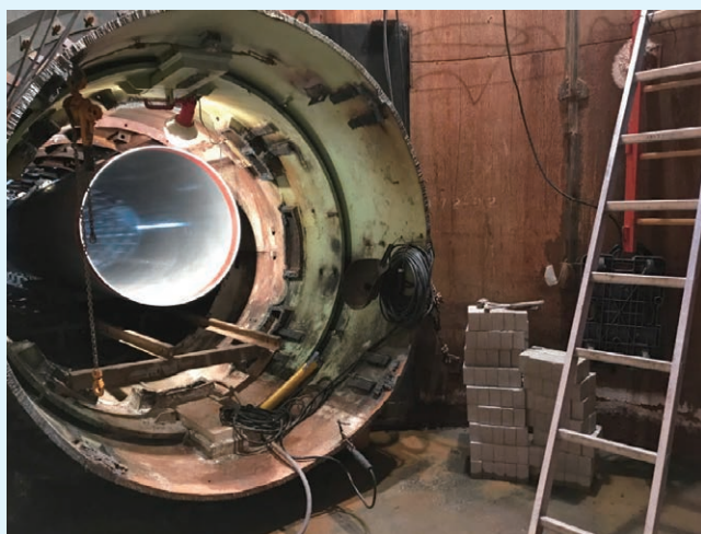
シールド部 鋼管布設状況
