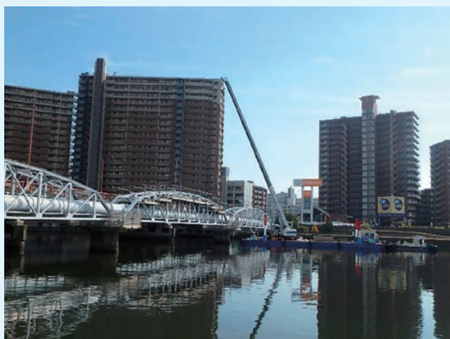
スパッド台船上のクレーンによる耐震補強作業状況
