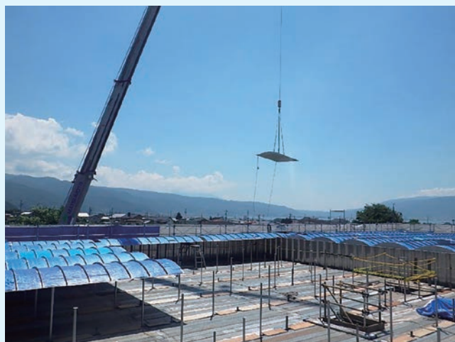
屋根板の据付け
