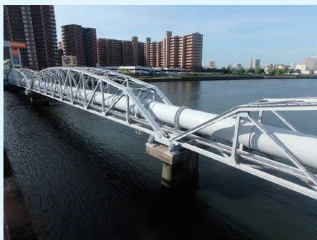
落橋防止装置・水管橋耐震補強
