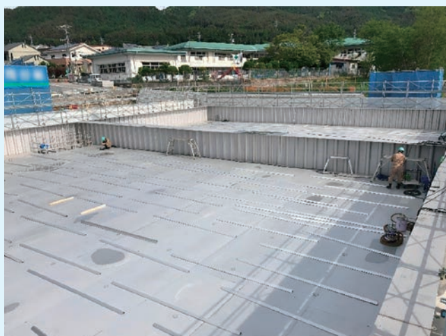
底板の据付け
