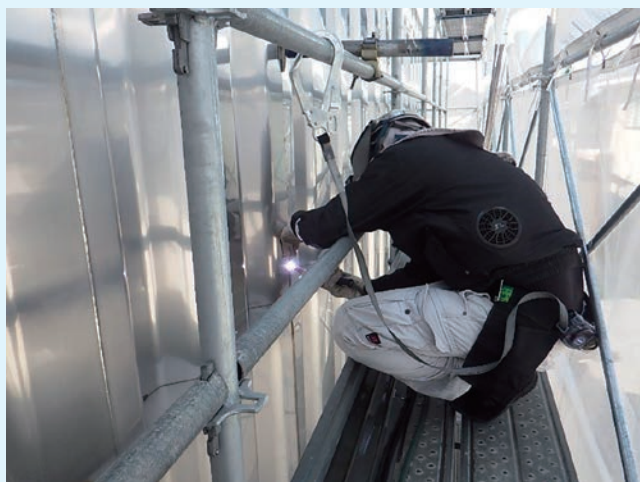
側板の溶接接合（TIG溶接）
