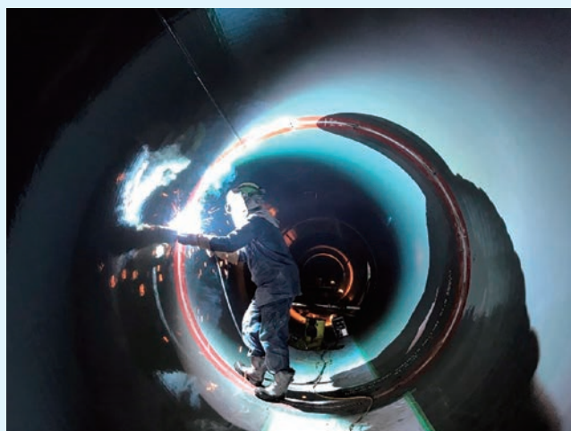
内面溶接状況
