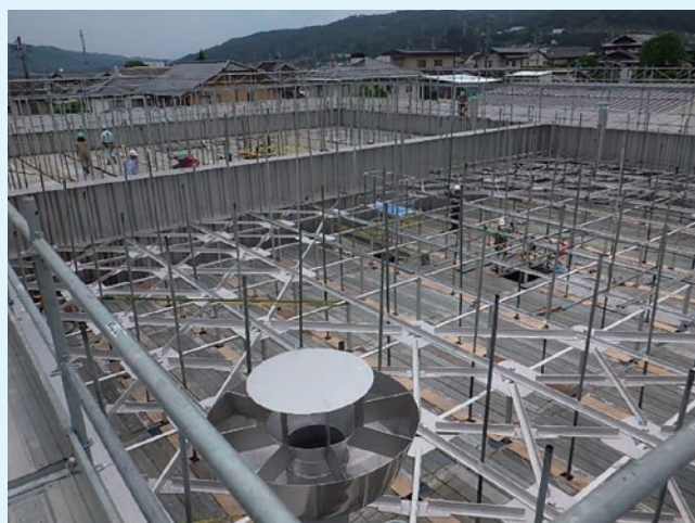
内部補剛材の組み立て
