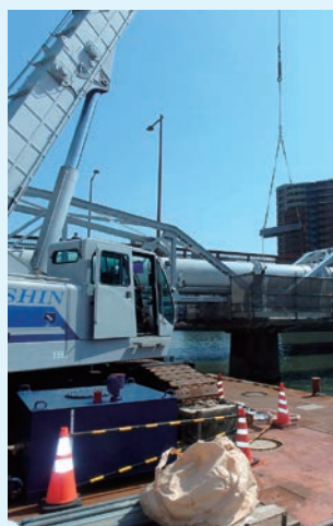
スパッド台船上のクレーンによる落橋防止装置設置状況
