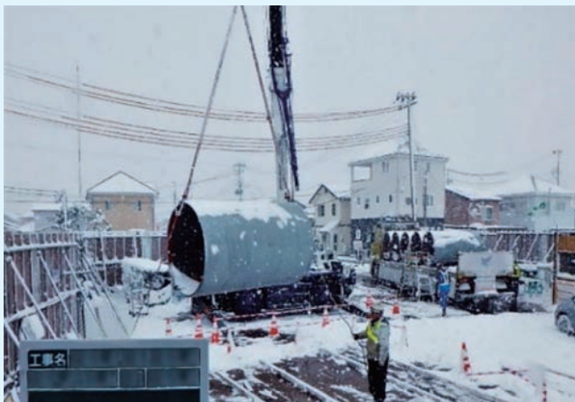
鋼管搬入状況
