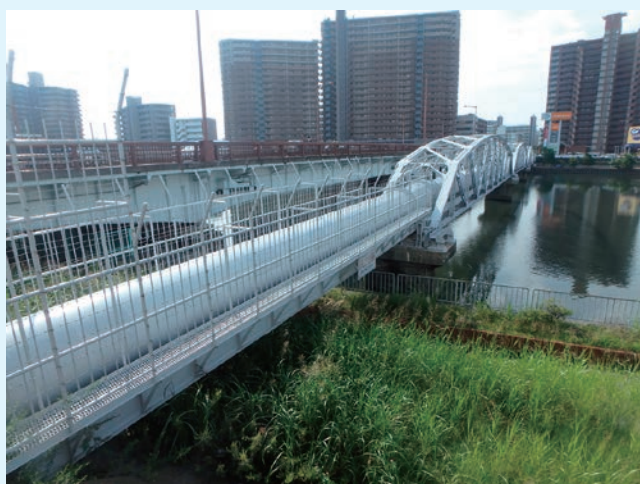
落橋防止装置・防護柵
