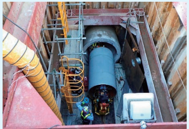
立坑内鋼管吊降し状況
