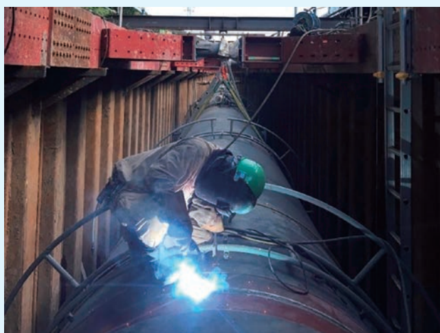
外面溶接状況
