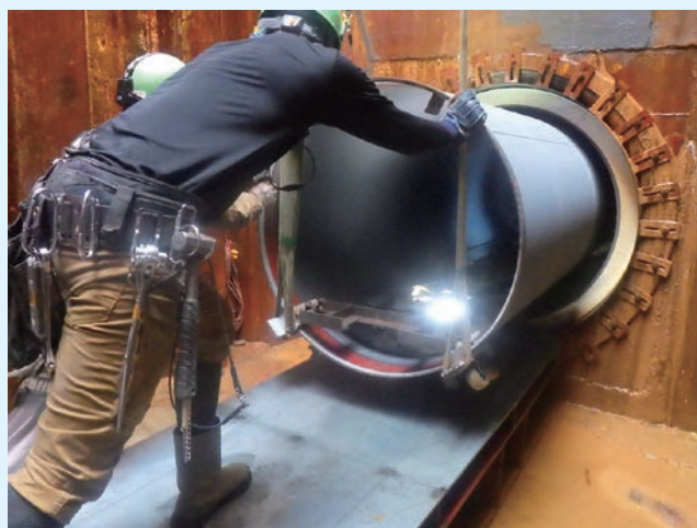
鋼管挿入状況
