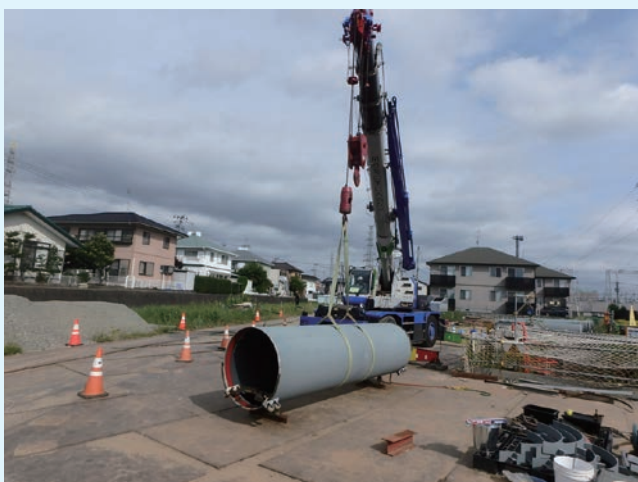
鋼管吊り降ろし状況
