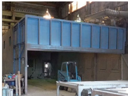
内部を閉め切り、密閉空間で作業します。
