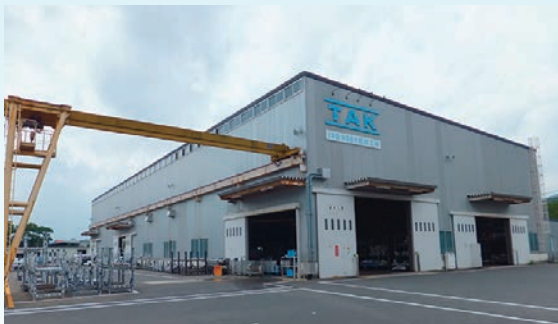
ナイロンコーティング鋼管が製造される工場棟
