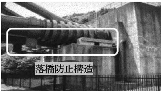
写真－1 落橋防止構造設置済み水管橋の状況
