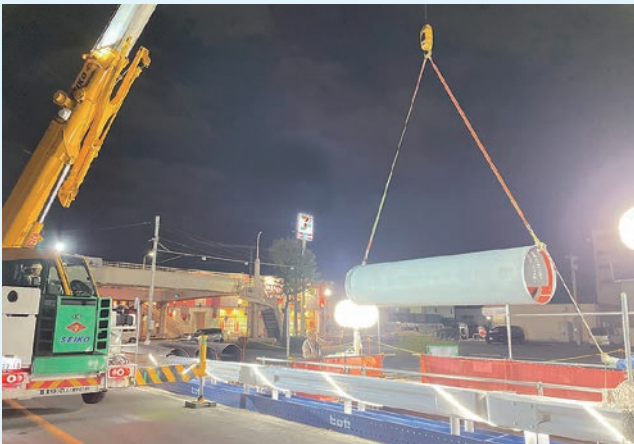
鋼管吊り込み状況
