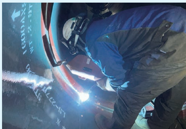
鋼管溶接状況
