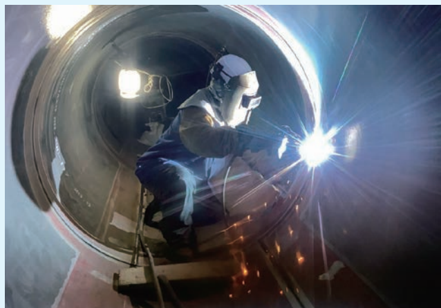
鋼管溶接状況
