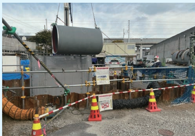
鋼管吊り下し状況
