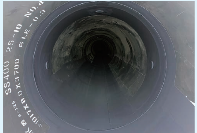
内面塗装完了
