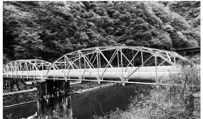
写真－3 武庫川第一水管橋（2026年撮影）
