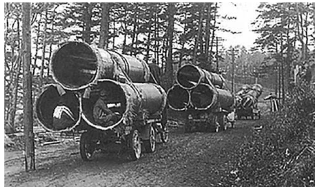
写真－4 昭和初期の鋼管運搬状況（横浜市水道局）
