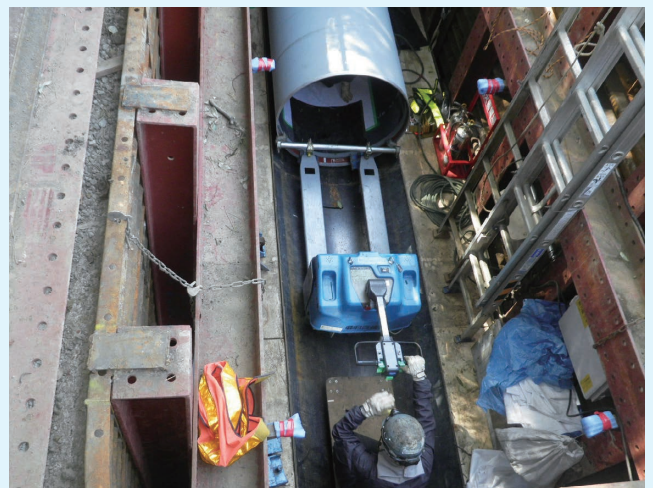
巻き込み鋼管挿入状況
