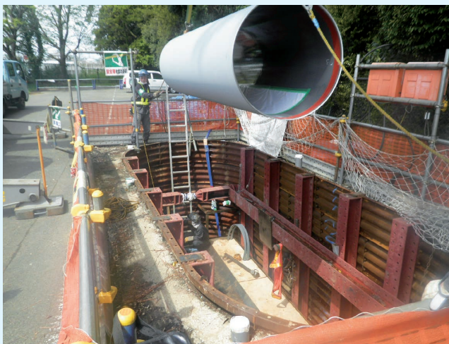
吊りおろし状況
